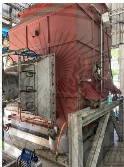
รูปที่ 2.8 เครื่องกำจัดฝุ่นแบบเปียก (Wet scrubber)
