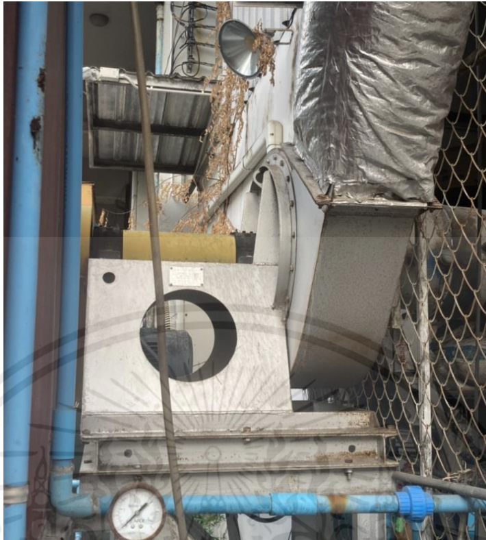
รูปที่ 4.15 แสดงลักษณะของ ID Fan
