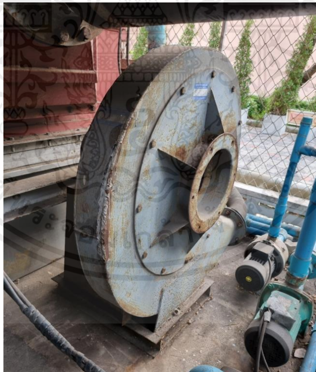
รูปที่ 4.14 แสดงลักษณะของ FD Fan ที่ป้อนอากาศทุติยภูมิ และตติยภูมิ
