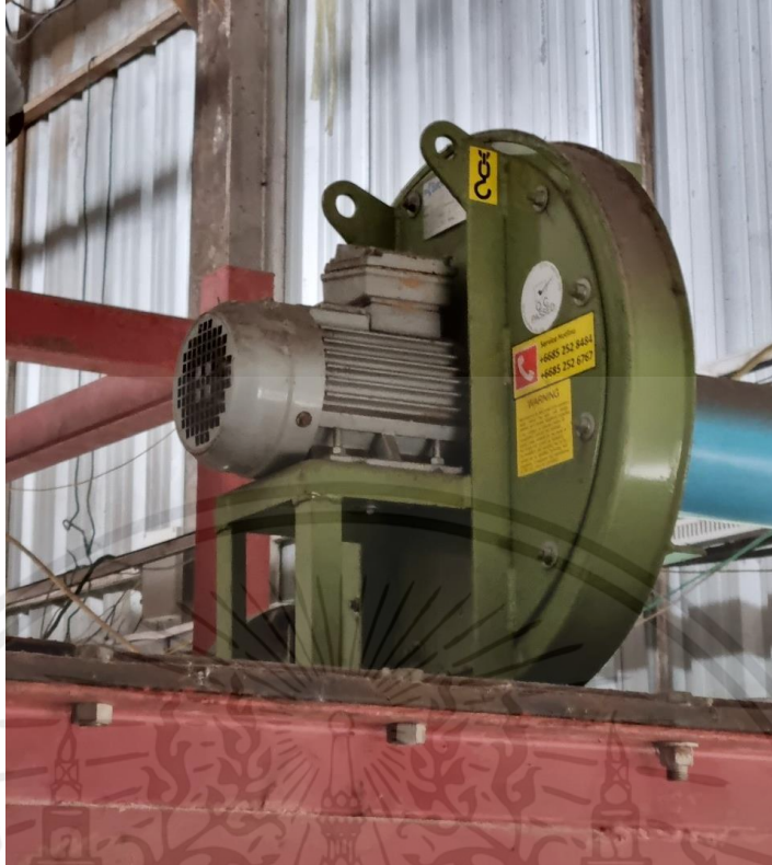
รูปที่ 4.13 แสดงลักษณะของ FD Fan ที่ป้อนอากาศปฐมภูมิ
