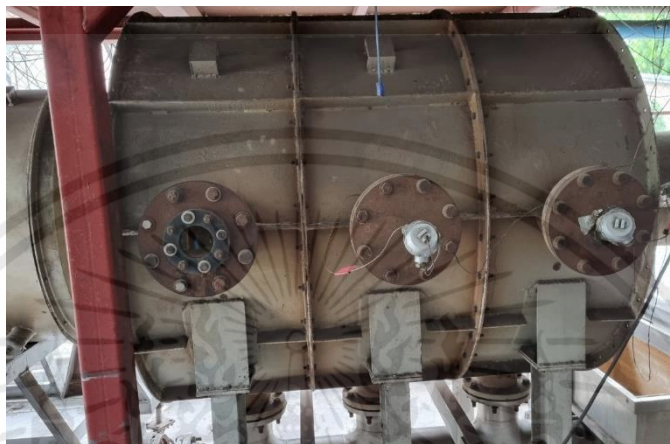
รูปที่ 4.5 แสดงห้องเผาไหม้หลัก
