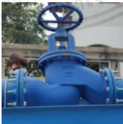
รูปที่ 3.6 Globe valve สำหรับควบคุมอัตราการไหล
