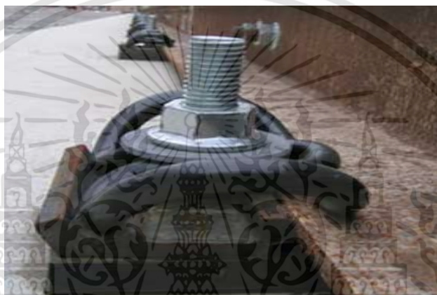
รูปที่ 2.2 คลิปยึดราง SKL บนรางรถไฟ
