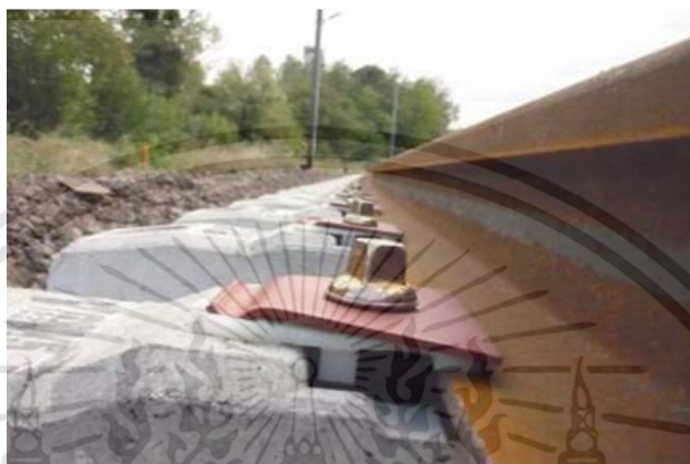
รูปที่ 2.3 คลิปยึดราง Nable บนรางรถไฟ
