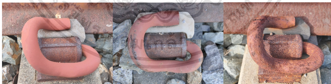
รูปที่ 3.5 แสดงถึงความแตกต่างของแต่ละคลาส No-rust, Rust และ Danger-rust ตามลำดับ
