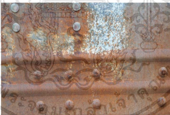
รูปที่ 2.8 สนิมน้ำตาลบนพื้นผิวโลหะ
