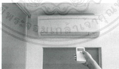
รูปที่ 47 เครื่องปรับอากาศแบบแยกส่วนชนิดติดผนัง
