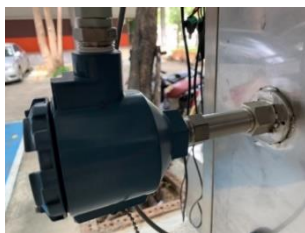
รูปที่ 3.12 ทำการติดตั้ง PT 100
