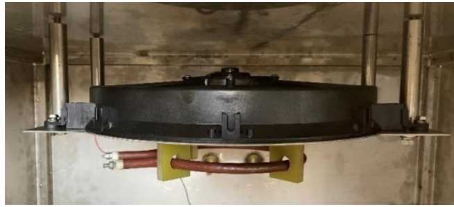
รูปที่ 3.24 ติดตั้งพัดลมหมุนเวียนอากาศ
