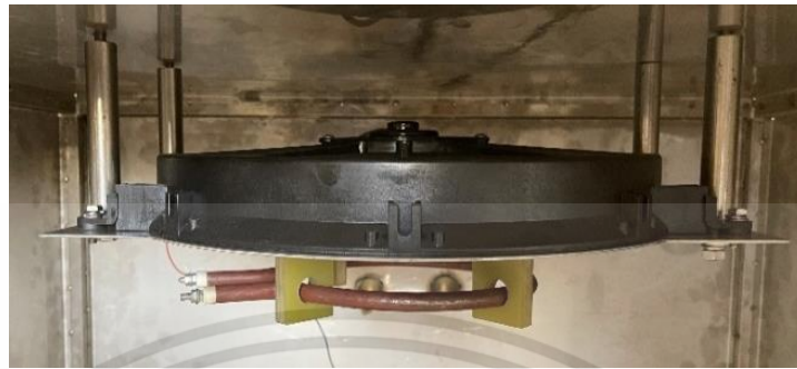
รูปที่ 3.14 ติดตั้งพัดลมระบาย
