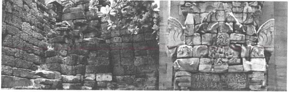
ภาพที่ 7-8 ภาพแสดงผนังหินก่อของปราสาทหินพิมาย
