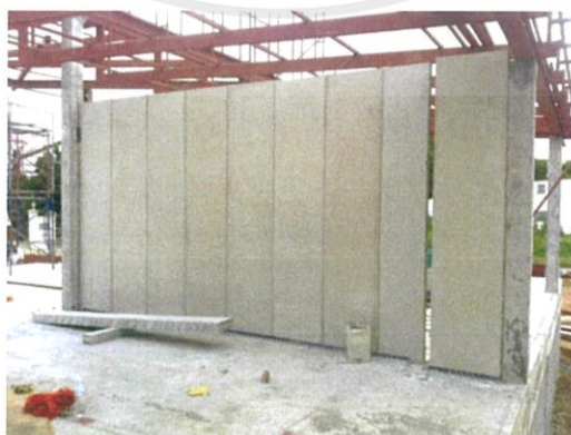
รูปที่ 7.3 แสดงลักษณะผนังสำเร็จรูป Pre-Cast
