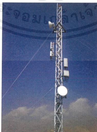
รูปที่ 2.11 Guyed Mast Tower [4]
