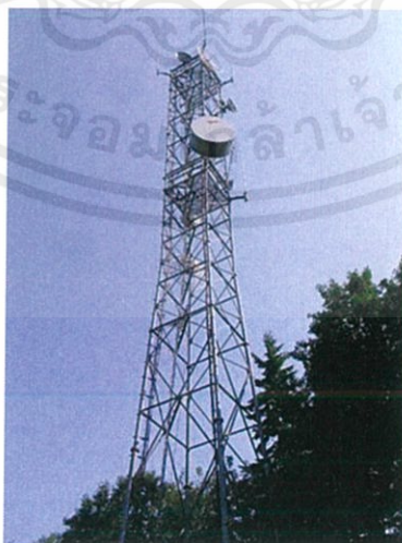
รูปที่ 2.8 Self Support Tower [4]
