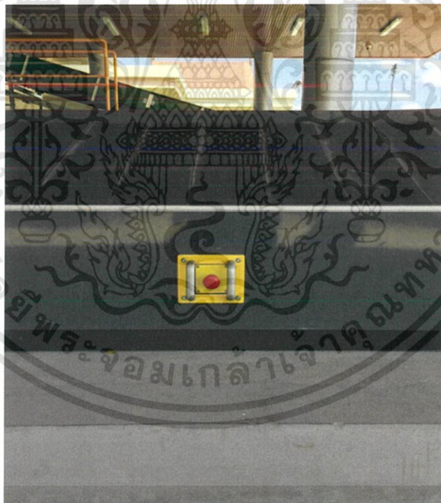
รูปที่ 2.17 ตัวอย่าง Emergency Stop ที่ Make up Unit
