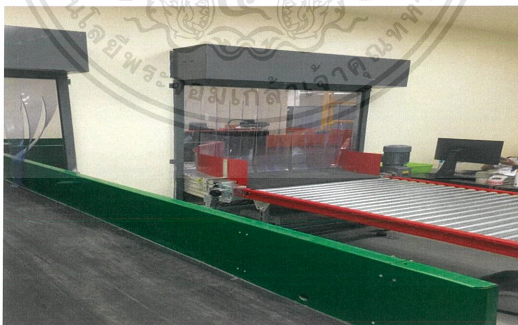
รูปที่ 2.33 ห้องตรวจสอบกระเป่า(Level 3)
