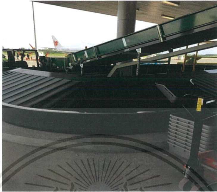
รูปที่ 2.36 Make Up Unit
