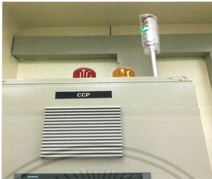
รูปที่ 2.14 ตัวอย่าง Tower Lamp บนตู้ควบคุม
