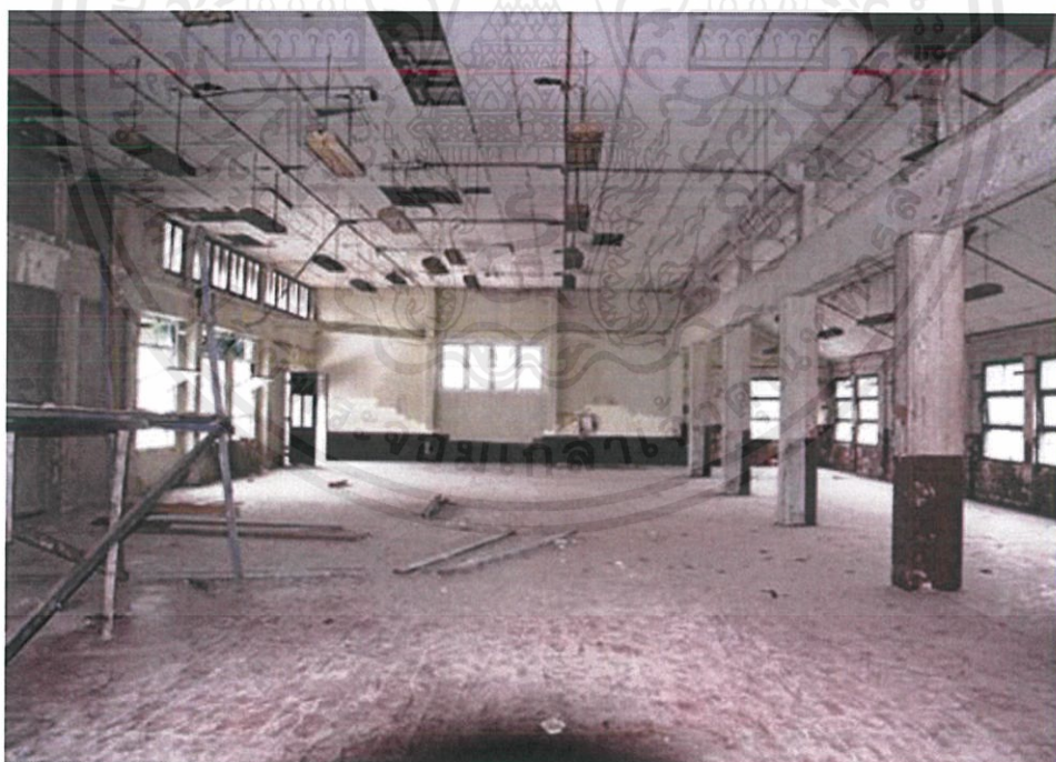
รูปที่4 ภายในอาคารเก็บพัสดุโรงงานยาสูบ
