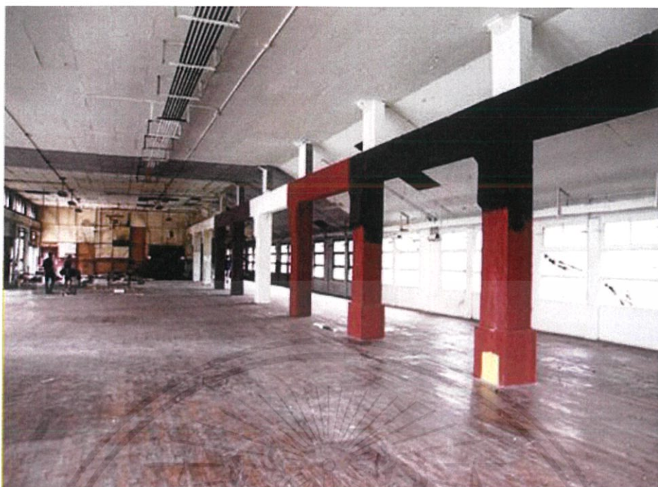
รูปที่3 ภายในอาคารเก็บพัสดุโรงงานยาสูบ
