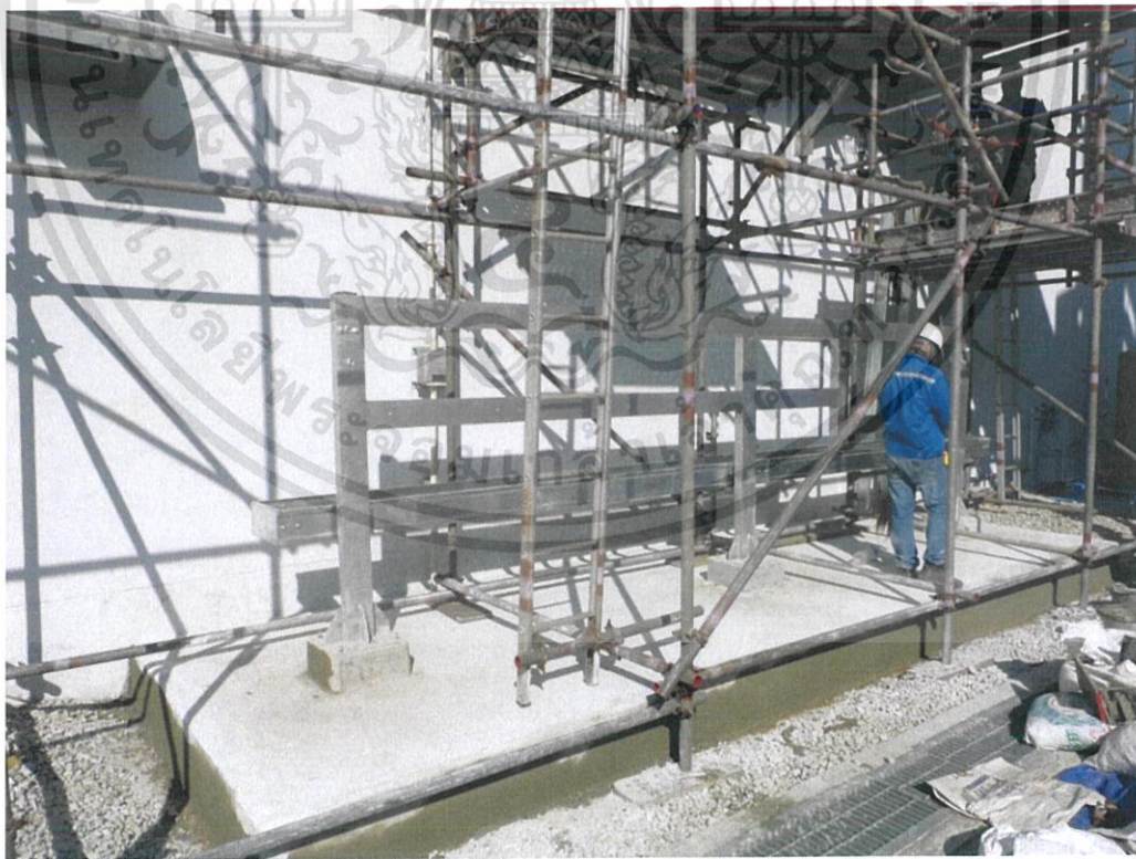
รูปที่ 3.23 รูปแสดงการติดตั้งโครงยึดกล่องพักสายไฟ และรางเก็บสายไฟ
