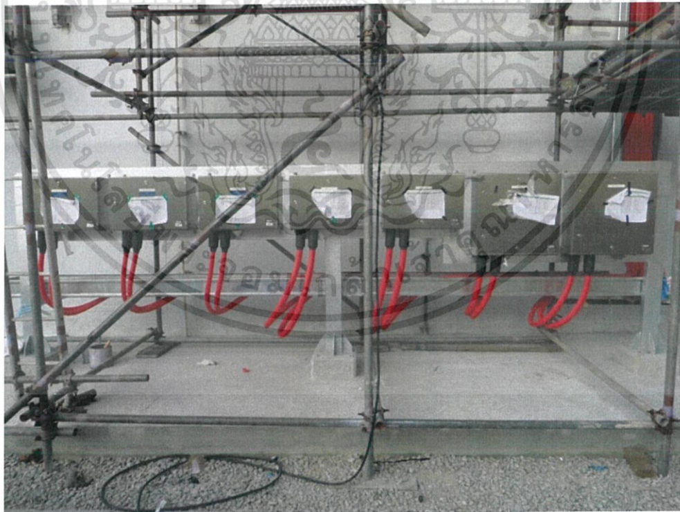
รูปที่ 3.27 รูปแสดงกล่องพักสายไฟที่ติดตั้ง และเชื่อมต่อสายสัญญาณเสร็จเรียบร้อยแล้ว
