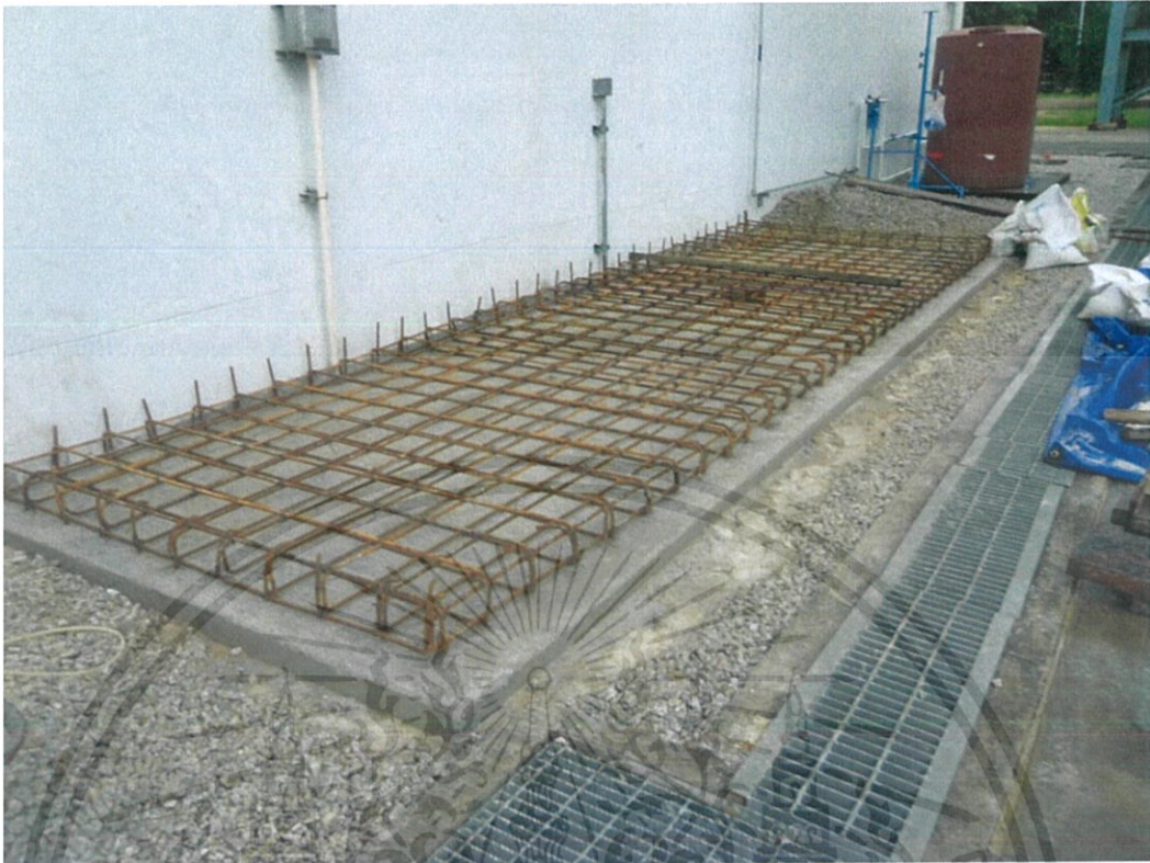
รูปที่ 3.22 แสดงการวางโครงสร้างฐานรากก่อนการเทปูน
