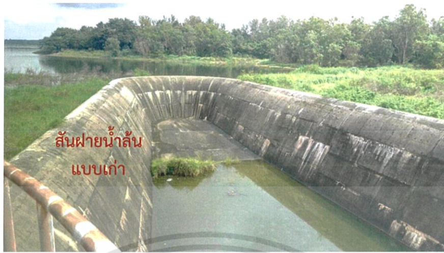
รูปที่ 2.3 สันฝายน้ำล้นแบบเก่าของอ่างเก็บน้ำหนองปลาไหล
