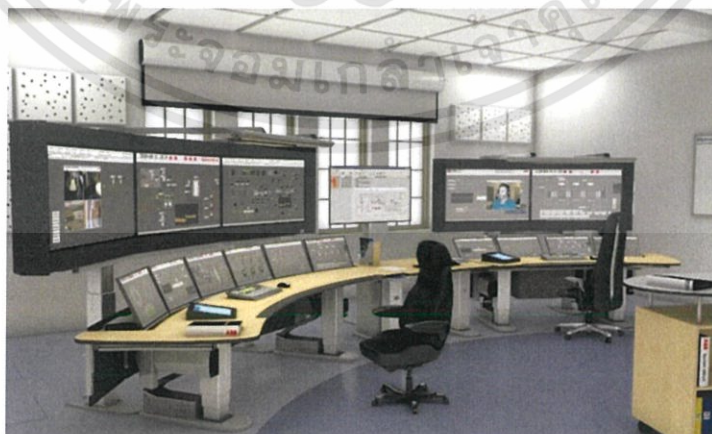
รูปที่ 2.4 Distributed Control System : DCS
