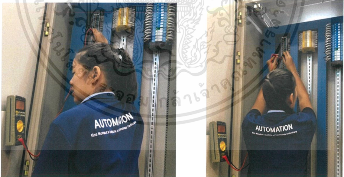
ภาพที่ 3.27 การวัดค่าเอาต์พุตที่ถูกจำลองค่ามาจากในโปรแกรม
