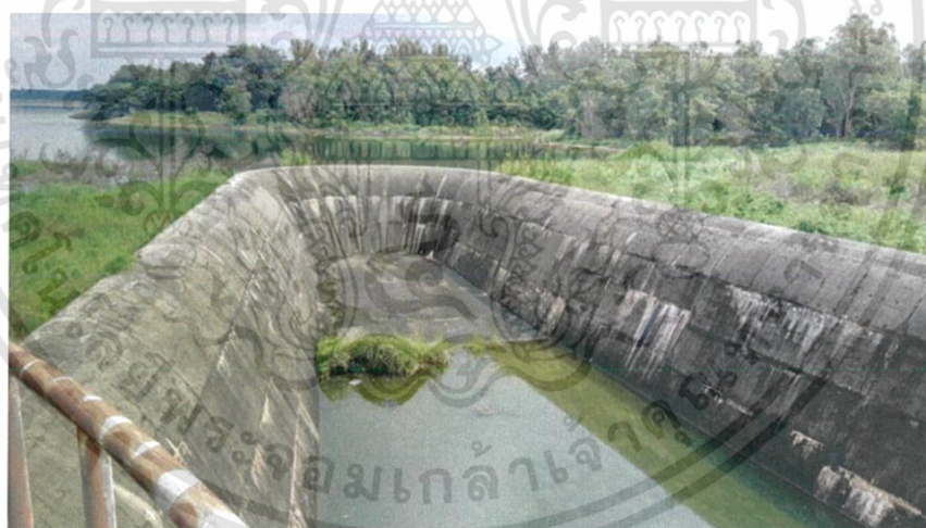
รูปที่ 2.2 ลักษณะสันอ่างเก็บน้ำหนองปลาไหล จ.ระยอง : HTTPS://TH.WIKIPEDIA.ORG/WIKI/ฝาย
