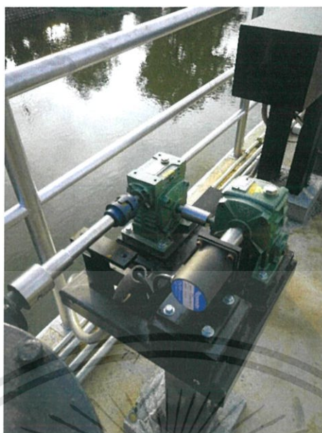
ภาพที่ 3.65 Encoder ต่อกับชุดเกียร์ทด
