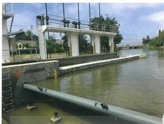
ภาพที่ 4.1 การสอบเทียบจุดสูงสุดและจุดต่ำสุดของฝายพับ
