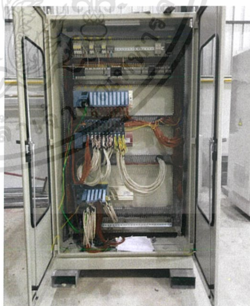
ภาพที่ 3.6 ทำการเดินสายไฟภายในตู้
