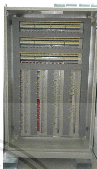
ภาพที่ 3.8 เก็บสายเข้ารางด้านหลัง
