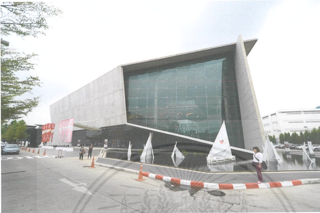
ภาพที่ 1.9 ด้านนอกอาคาร โดยรวม
