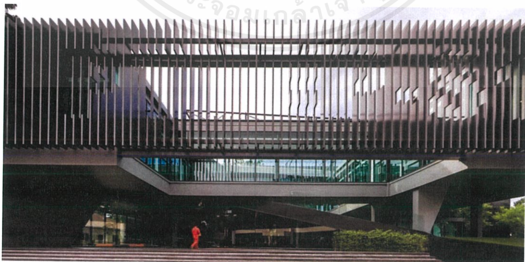
รูปที่ 1.7.2 อาคารPPTEP-S1 Office
