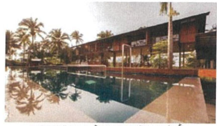
บรรยากาศของอาคารร้านอาหาร และบริเวณสระว่ายน้ำ
