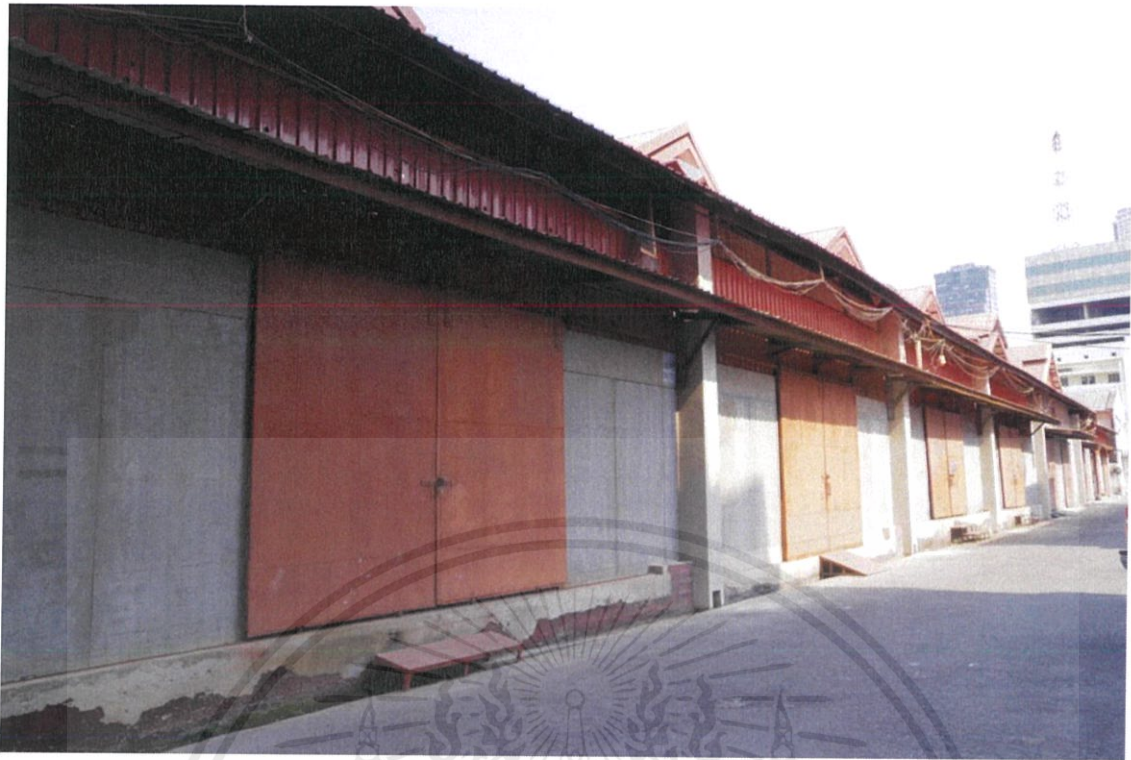
รูปที่ 1.6.1 อาคารโกดัง Warehouse30
