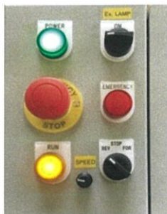
รูปที่ 3.47 ไฟลอตแลมป์แสดงสถานะใช้งานของมอเตอร์
