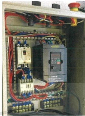
รูปที่ 3.35 การเดินสายไฟและสายควบคุมตามแบบไฟฟ้า
