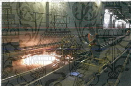
รูปที่ 4.1 การใช้งานเครื่องเจียรรางรุ่น MV-03 ก่อนการติดตั้งระบบขับเคลื่อน
