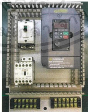
รูปที่ 3.34 การติดตั้งอุปกรณ์ตามตำแหน่งที่กำหนดไว้
