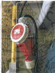
รูปที่ 3.42 ปลั๊กไฟสามเฟสตัวผู้และตัวเมีย
