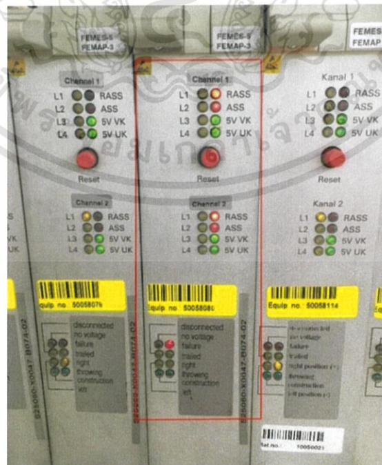
รูปที่ 5.2 แสดงการเกิด failure ที่หน้าการ์ดควบคุม (WESTE)
