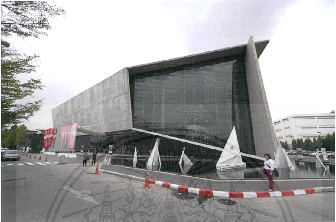
ภาพที่ 1.6.2.1 ด้านนอกอาคาร โดยรวม
