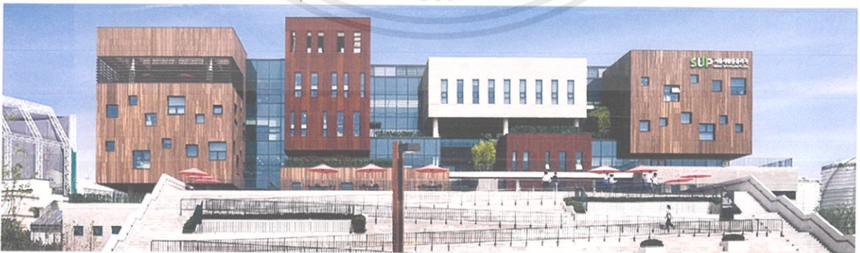
ภาพที่ 2.6.1 แสดงภาพอาคารภายนอกของโครงการ
