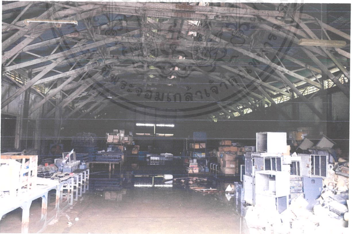
ภาพที่ 1.8.4 ภาพอาคารภายใน
