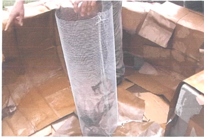
ภาพที่ 2.7.3 แสดงการนำตะแกรงเหล็กมาวางกลางหลุม
