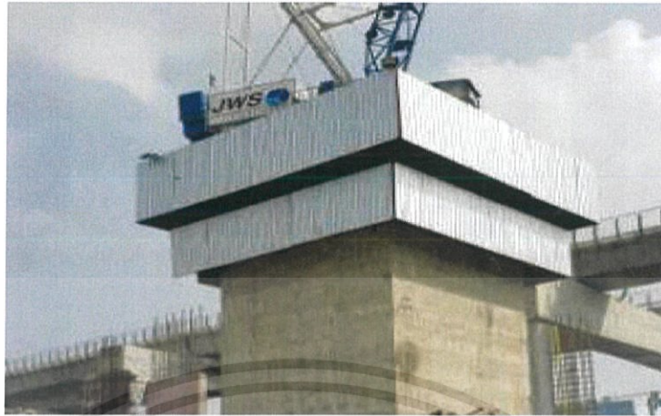
ภาพที่ 2.14 ภาพSlipform ภายในหน่วยงาน ( ที่มา : หน่วยงาน The Privacy Tha-Phra Interchange )
