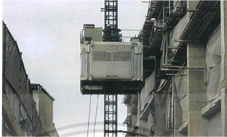
ภาพที่ 2.16 ภาพ Passenger Hoist ภายในหน่วยงาน ( ที่มา : หน่วยงาน The Privacy Tha-Phra Interchange )
