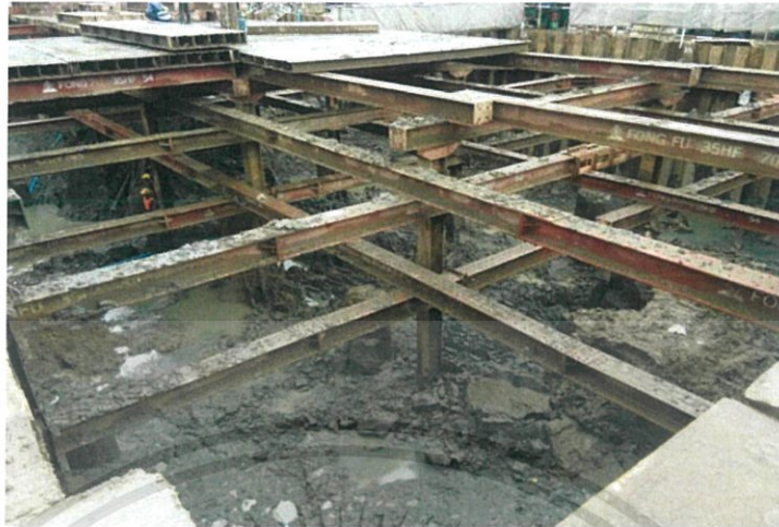
ภาพที่ 2.5 ภาพการวางแผนเหล็กพื้น (ที่มา : หน่วยงานThe Privacy Tha-Phra Interchange )
