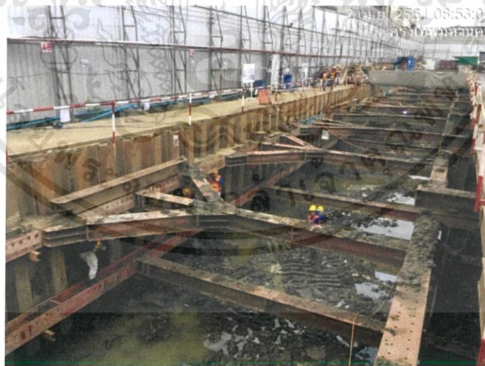
ภาพที่ 2.6 ภาพการติดตั้ง Wale และ Strut layer 2 (ที่มา : หน่วยงานThe Privacy Tha-Phra Interchange )
