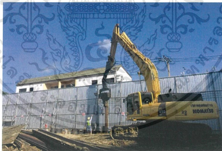
ภาพที่ 2.3 ภาพ Vibro hammer ปักแผ่น Sheet pile ( ที่มา : หน่วยงาน The Privacy Tha-Phra Interchange )
