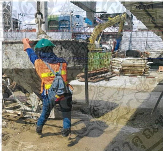
ภาพที่ 2.17 ภาพ Pocket Concrete ภายในหน่วยงาน ( ที่มา : หน่วยงาน The Privacy Tha-Phra Interchange )
