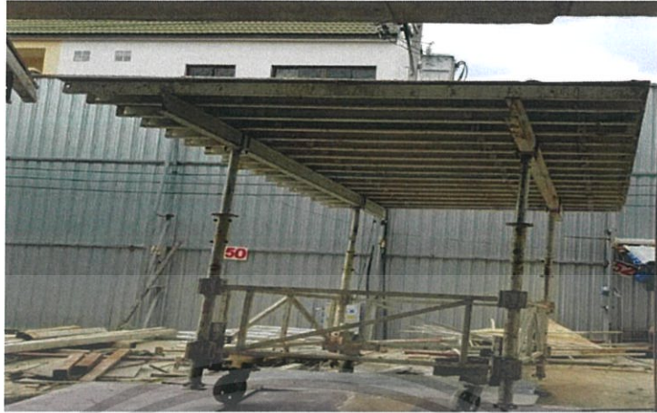
ภาพที่ 2.20 ภาพ Table form ภายในหน่วยงาน ( ที่มา : หน่วยงาน The Privacy Tha-Phra Interchange )
