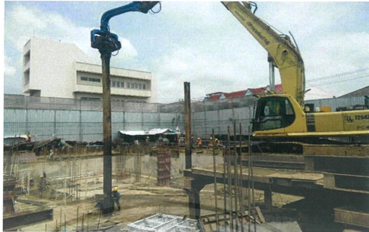
ภาพที่ 2.12 ภาพ Vibro Hammer ภายในหน่วยงาน ( ที่มา : หน่วยงาน The Privacy Tha-Phra Interchange )
