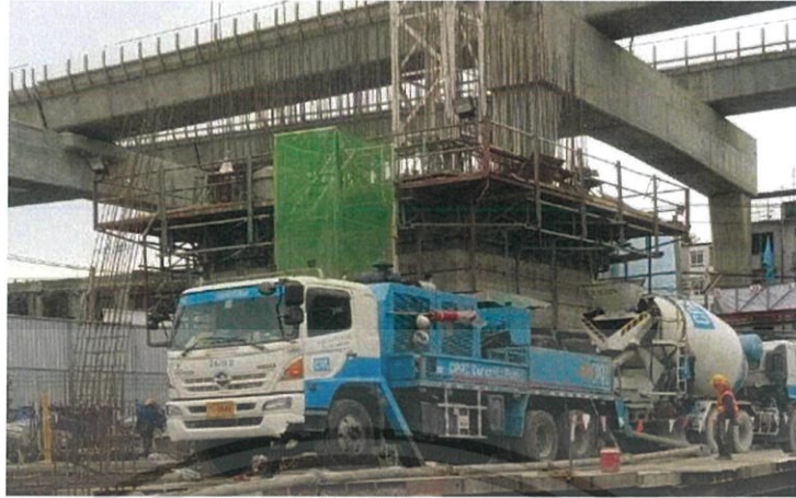
ภาพที่ 2.18 ภาพ Station Pump ภายในหน่วยงาน ( ที่มา : หน่วยงาน The Privacy Tha-Phra Interchange )
