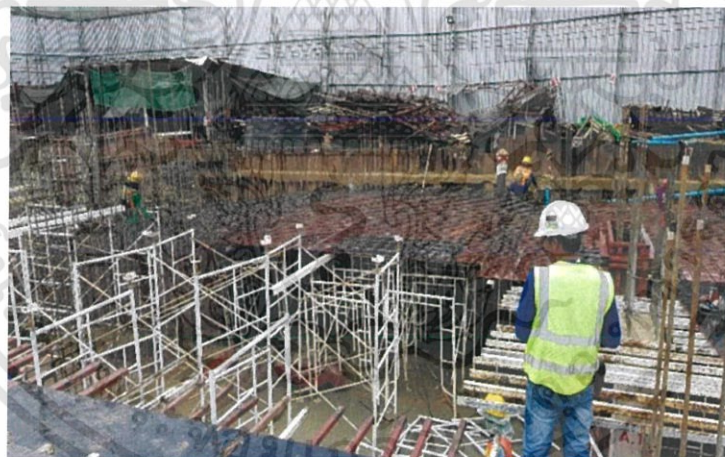
ภาพที่ 2.19 ภาพน้้งร้านภายในหน่วยงาน ( ที่มา : หน่วยงาน The Privacy Tha-Phra Interchange )
