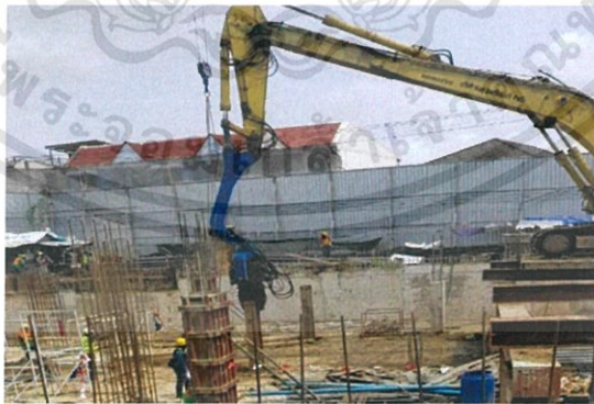
ภาพที่ 2.8ภาพ Vibro hammer ถอนเสา Kingpost ( ที่มา : หน่วยงาน The Privacy Tha-Phra Interchange )
