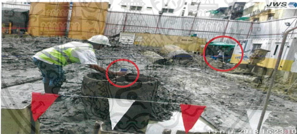
รูปที่ 3.7 ตรวจสอบพิกัดปลอกเหล็ก ( ที่มา: โครงการ The Fine Bangkok )
