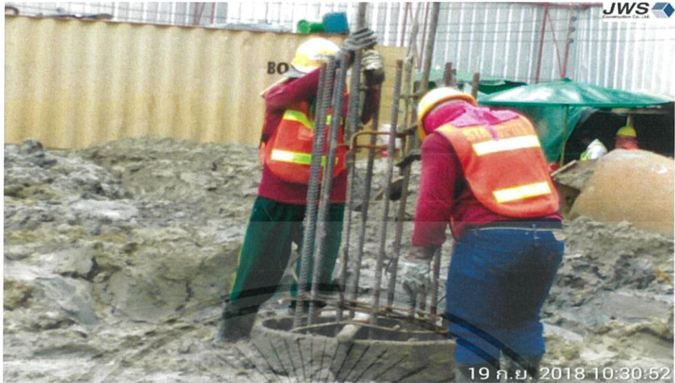
รูปที่ 3.10 การใส่เหล็กเสริมในหลุมเจาะ ( ที่มา: โครงการ The Fine Bangkok )
