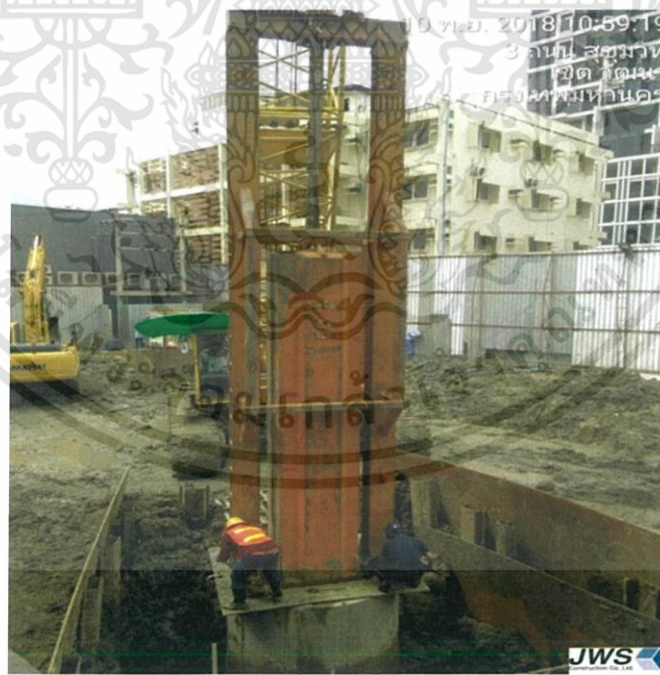
รูปที่ 3.15 การทดสอบกำลังรับน้ำหนักของเสาเข็มด้วยวิธี Dynamic Load Test (ที่มา: โครงการ The Fine Bangkok)
