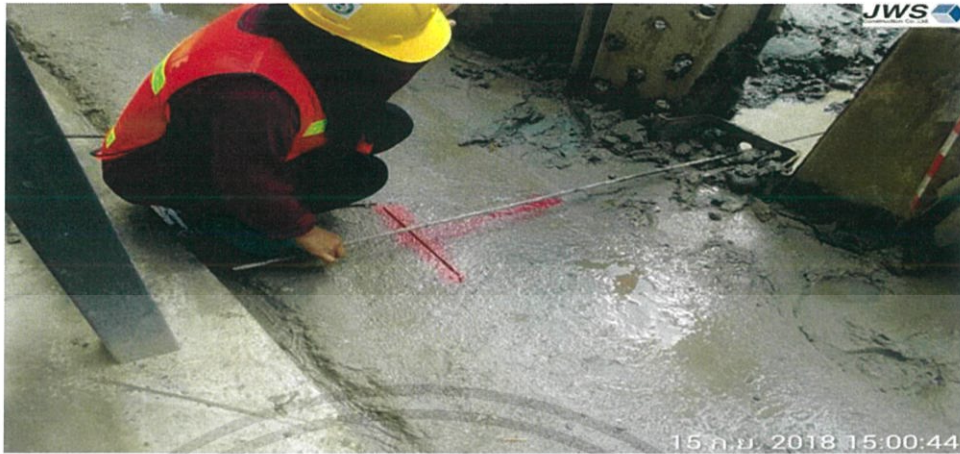
รูปที่ 3.6 ควบคุมตำแหน่งปลอกเหล็กด้วยเหล็กเส้น ( ที่มา: โครงการ The Fine Bangkok )
