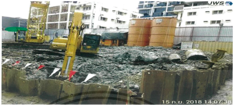
รูปที่ 3.4 Back Hoe ขุดเปิดหน้าดิน (ที่มา: โครงการ The Fine Bangkok)
