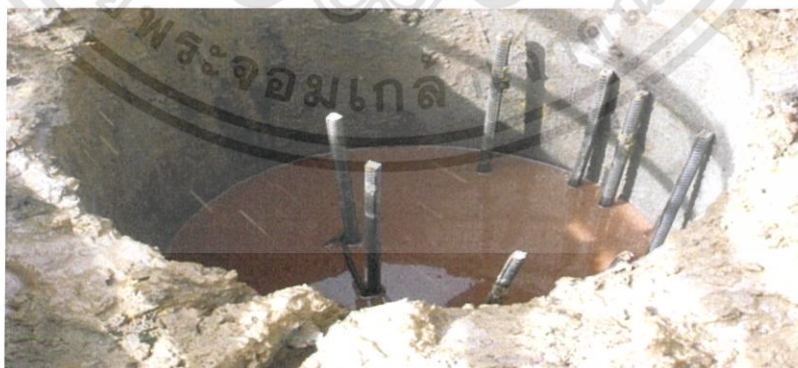
รูปที่ 2.6 เสาเข็มเจาะระบบเปียก
