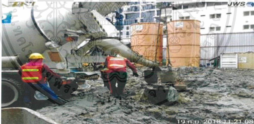
รูปที่ 3.12 การเทคอนกรีต
