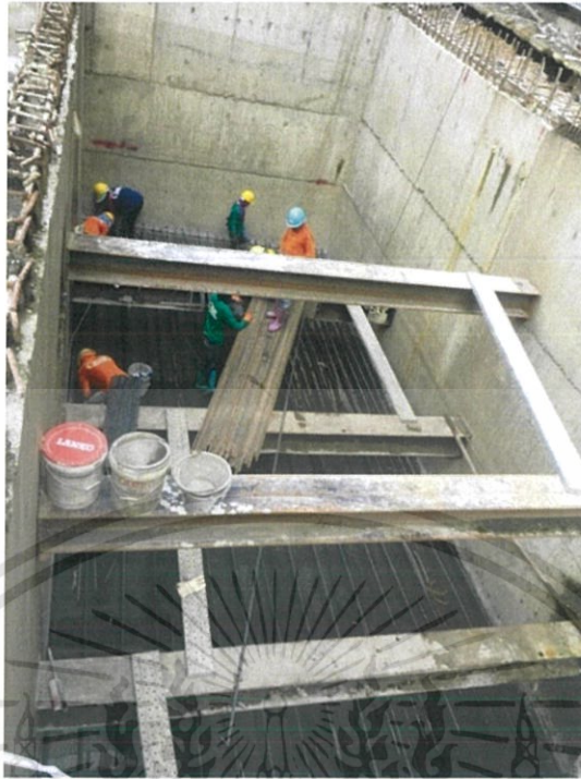
ภาพที่ 3.28 แสดงการลงเหล็กเสริมพื้น
