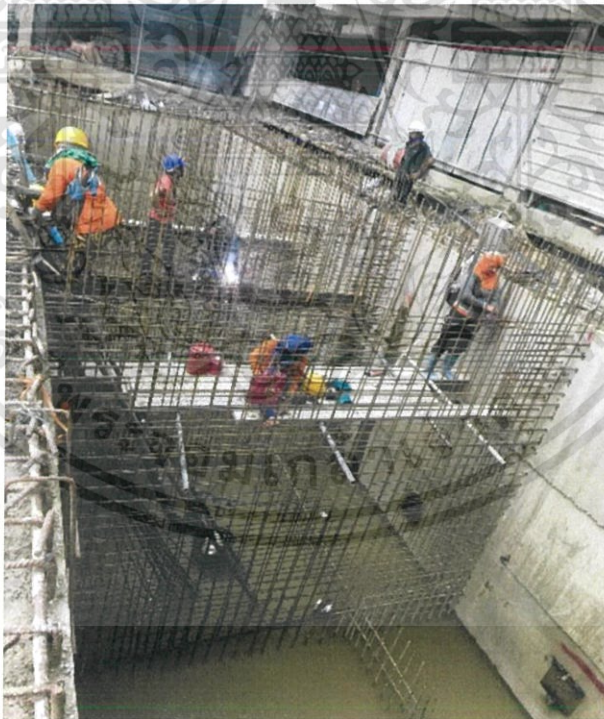
ภาพที่ 3.29 แสดงการวางเหล็กเสริมผนังย่อย
