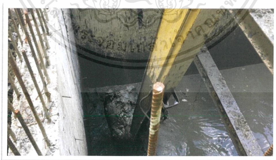
ภาพที่ 4.3 แสดงการตักดินออกขณะที่น้ำใต้ดินท่วมเต็มบ่อทำให้ดินที่ขึ้นมาเป็นดินเลน
