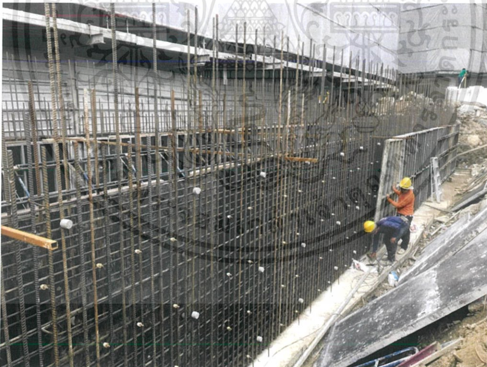
ภาพที่ 3.6 แสดงการวางเหล็กและเข้าแบบนอก
