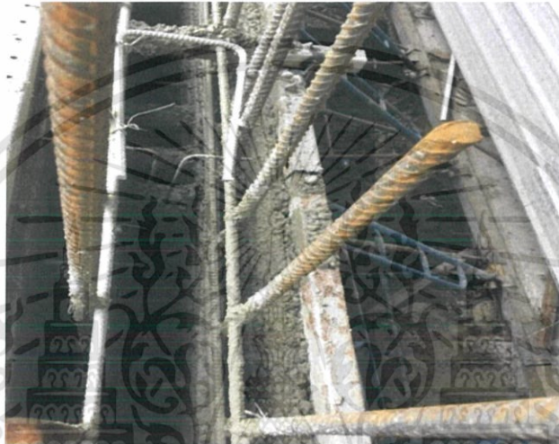
ภาพที่ 4.4 แสดงการละเลยไม่ใส่แผ่นยางกันน้ำ
