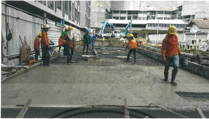
ภาพที่ 3.33 แสดงการคอนกรีตฝ้าป่อ
