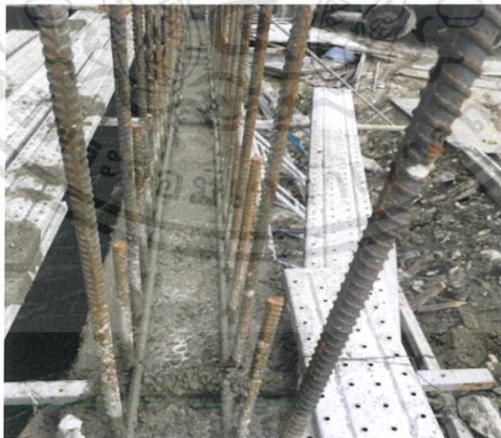
ภาพที่ 4.5 แสดงเมื่อเทพื้นบ่อแล้วเสร็จแต่ไม่ใส่แผ่นยางกันน้ำ
