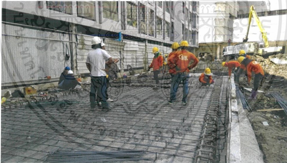
ภาพที่ 3.32 แสดงการลงเหล็กเสริมฝาบ่อ
