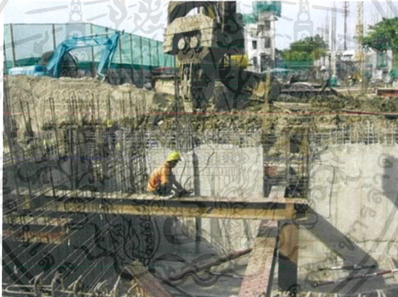
ภาพที่ 4.1 แสดงวิธีการก่อสร้างโดยใช้เข็มพืดเหล็ก
