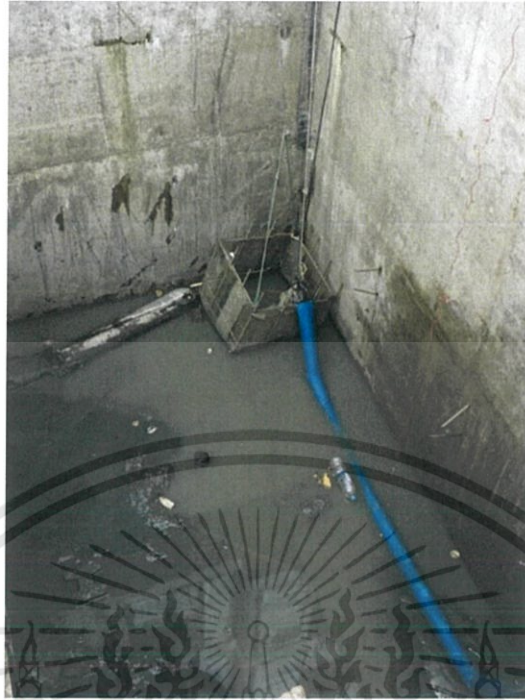
ภาพที่ 3.26 แสดง Sump เพื่อดูค่าน้ำออกจากบ่อตลอดเวลา
