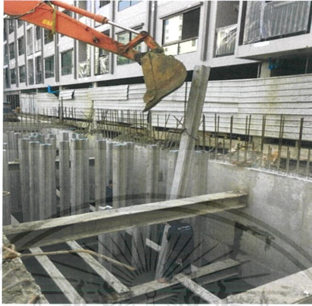
ภาพที่ 3.22 แสดงการย้ายเสาเข็มเพื่อดำเนินการตอก
