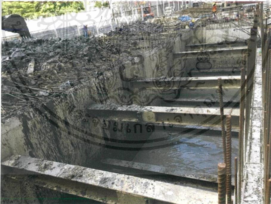
ภาพที่ 3.20 แสดงการถมของผนังบ่อเมื่อได้ระดับในชั้นที่ 2
