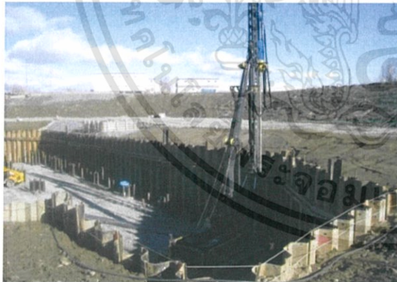
ภาพที่ 2.9 แสดงการปักเข็มพืดเหล็ก
