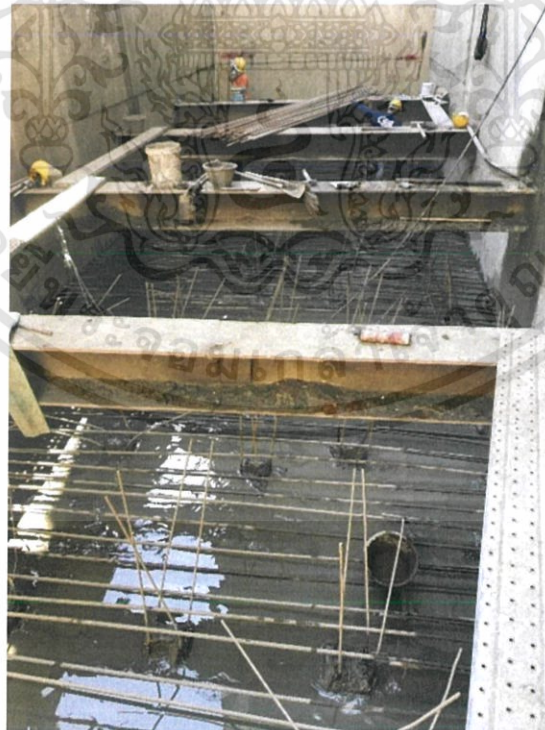
ภาพที่ 3.27 แสดงเหล็ก Dowel ที่ยื่นออกมาจากหัวเสาเข็ม
