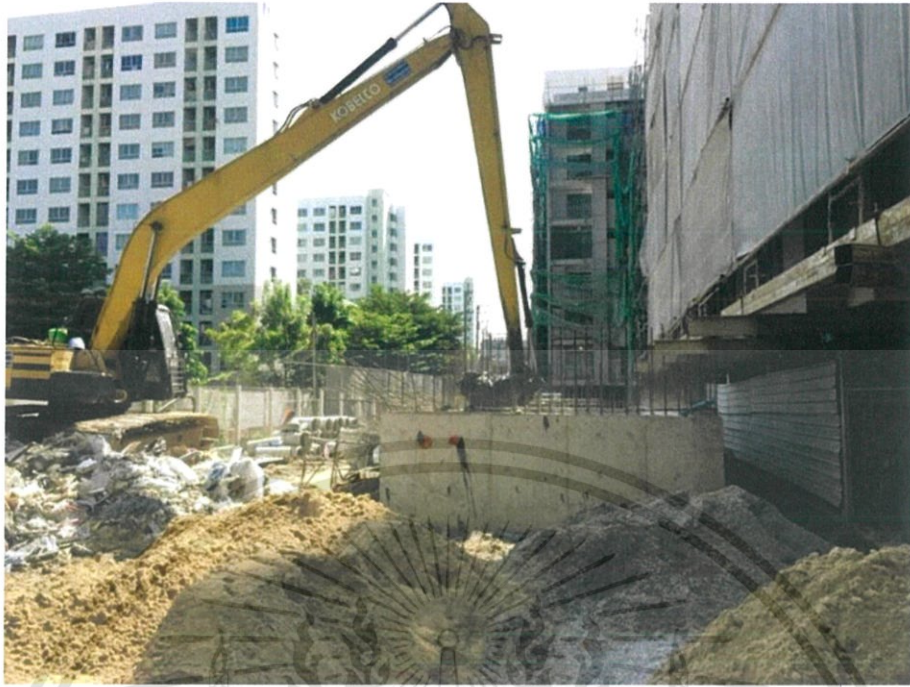
ภาพที่ 3.19 แสดงกาขุดดินภายในบ่อเพื่อทำการถมชั้นที่ 2
