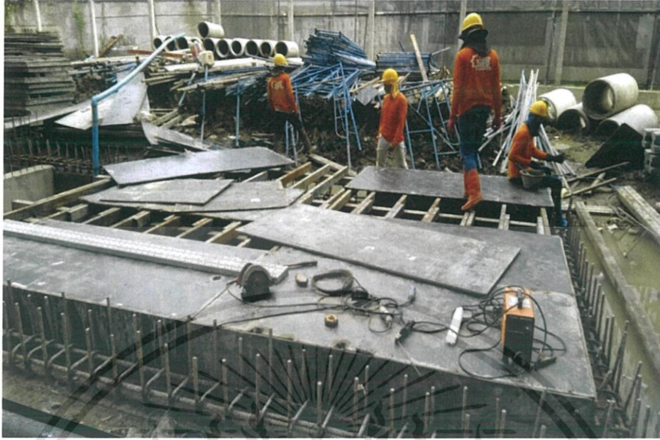
ภาพที่ 3.31 แสดงการตั้งนั่งร้านและเข้าแบบเพื่อเทพาบ่อ
