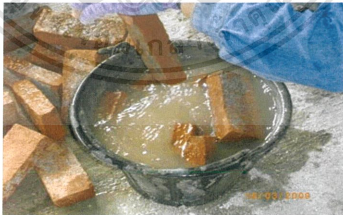
รูปที่ 2.4 การนำอิฐแช่น้ำหรือรดน้ำให้อิฐดูดน้ำจนอิ่มตัว
