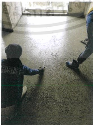
รูปที่ 3.32 ใช้เกรียงเหล็กปาดแต่งปูนให้เรียบอีกครั้ง
