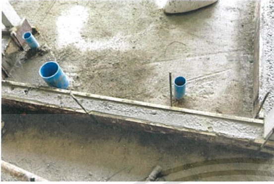
รูปที่ 3.13 เทปูนลงในแบบโดยใช้ชั้นเหล็กยึด บริเวณข้างแบบ
