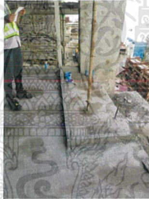
รูปที่ 3.15 ถอดแบบ Curb หลังผ่านเวลา 12-24 ชั่วโมง
