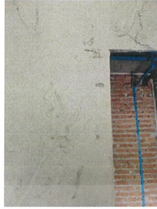
รูปที่ 3.52 ผนังมีการฉาบไม่เต็มความหนา
