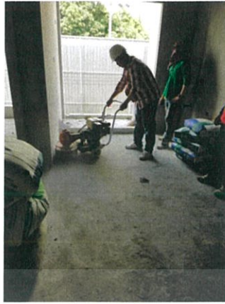
รูปที่ 3.27 ขัดผิวหน้าพื้นคอนกรีตให้เรียบ
