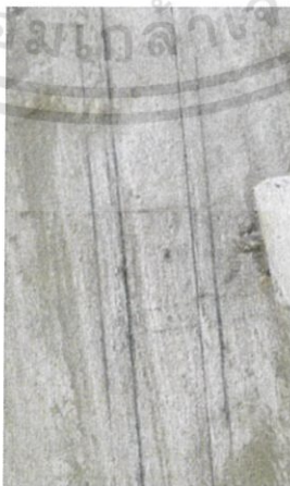
รูปที่ 3.35 ลักษณะการตีเส้นไลน์
