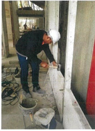
รูปที่ 3.21 ใช้ก้อนยางเคาะอิฐให้แน่นและได้แนวก่อ
