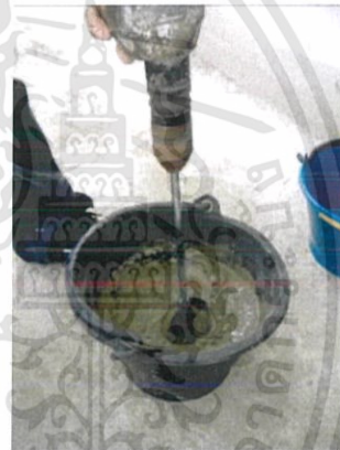
รูปที่ 2.23 การผสมปูนก่อกับน้ำด้วยหัวปั่นรูปที่ 1 รูปที่ 2.24 การผสมปูนก่อกับน้ำด้วยหัวปั่นรูปที่ 2
