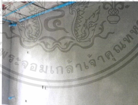
รูปที่ 3.26 ผนังฉาบหลังผ่านการขัดฟอง
