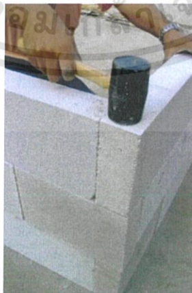
รูปที่ 2.46 การก่ออิฐมวลเบาแบบประสานมุม
