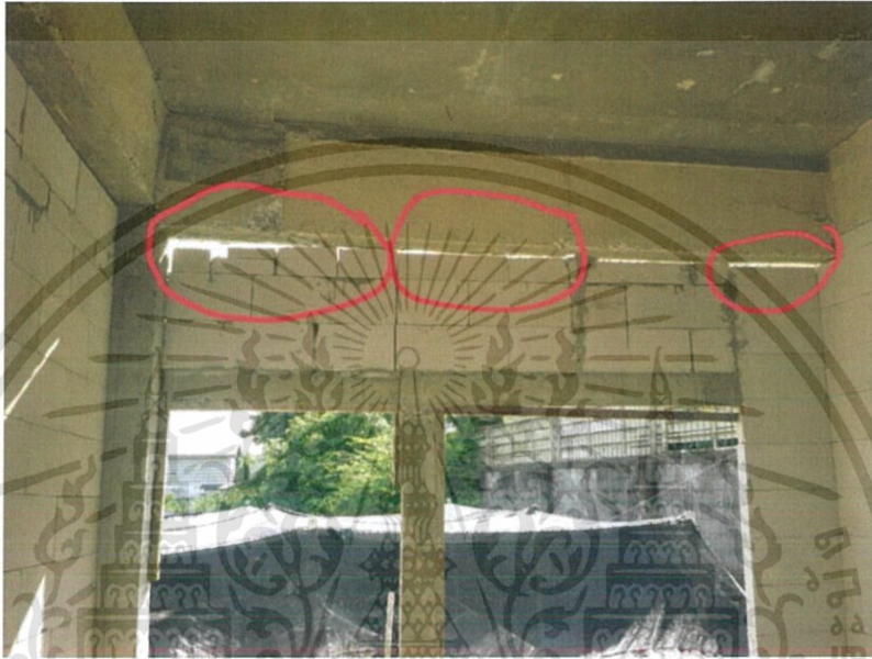
รูปที่ 2.57 ช่องว่างระหว่างแนวก่ออิฐ (ที่มารูป https://pantip.com/topic/32322124 )
