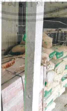
รูปที่ 3.9 ตั้งเลเซอร์ตรวจเช็คความตรงของผิวหน้าเสาเอ็น
