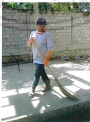
รูปที่ 2.25 ทำความสะอาดเตรียมก่ออิฐ
