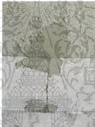
รูปที่ 3.48 การใช้ปูนก่ออุดรูแนวก่อผนัง
