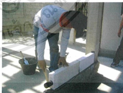
รูปที่ 2.35 ใช้ก้อนยางเคาะด้านข้างอิฐก่อนต่อมาให้สนิท
