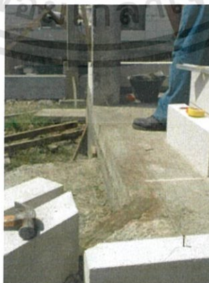
รูปที่ 2.22 การชั่งเอ็นเพื่อกำหนดระดับหลัง Block
