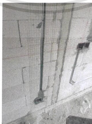
รูปที่ 3.38 การติดตะแกรงกรงไว้บริเวณรอยต่อผนัง และรอบช่องเปิด
