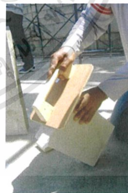
รูปที่ 2.40 ใช้เกรียงฟันปลาขีดให้ผิวอิฐ เรียบเสมอรูปที่ 2
