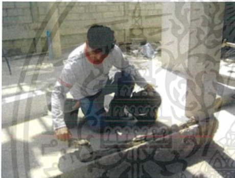
รูปที่ 2.27 ใช้ปูนก่อรองอิฐชั้นแรกรูปที่ 1
