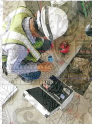
รูปที่ 3.34 ตั้งเลเซอร์เช็คแนวจากตามจุดตัด
