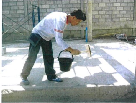
รูปที่ 2.26 ใช้เปรงตีน้ำทำความสะอาด
