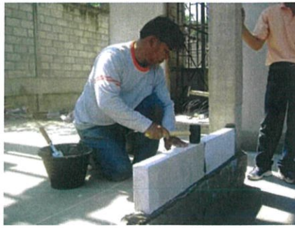
รูปที่ 2.36 ใช้ค้อนยางเคาะด้านบนอิฐก่อนต่อมาให้สนิท (ที่มาภาพ : ข้อมูลกระบวนการติดตั้งของบริษัท JWS Construction)
