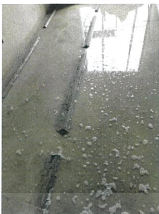
รูปที่ 3.30 การบ่มน้ำก่อนการเทพรับพื้น
