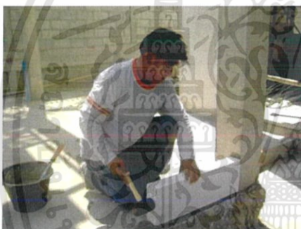
รูปที่ 2.32 ใช้ก้อนยางเคาะด้านข้างอิฐให้สนิท
