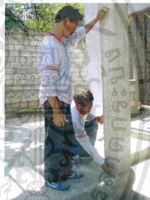
รูปที่ 2.21 การกำหนดแนวก่อตามแบบรูปที่ 2
