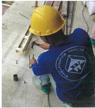
รูปที่ 3.7 เสียบเหล็กหนวดกุ้ง โดยใช้ค้อนตอก
