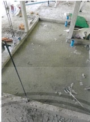
รูปที่ 3.36 การขังน้ำเวลานาน 12-24 ชั่วโมง เพื่อตรวจเช็คการรั่วซึมของ Curb
