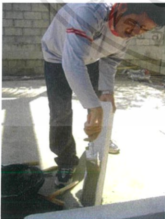
รูปที่ 2.29 ทาปูนก่อด้านบนอิฐมวลเบารูปที่ 1
