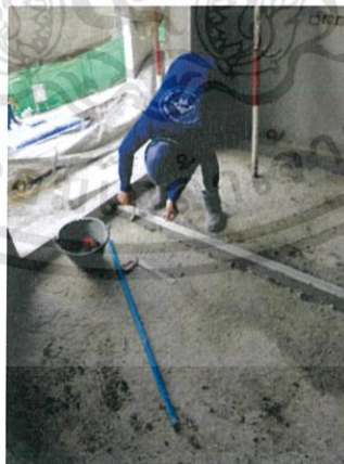
รูปที่ 3.29 กำหนดระดับเทปรับโดยจับปูนแต่งเป็นคันทรงสามเหลี่ยมทอดยาว
