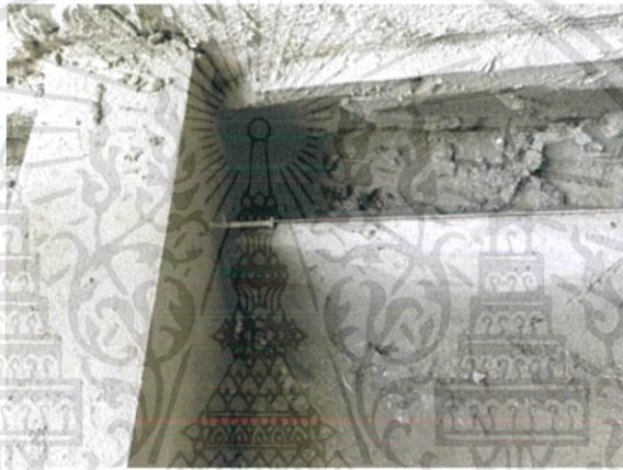
รูปที่ 3.28 ขึงเอ็นกำหนดระดับการจับปูน
