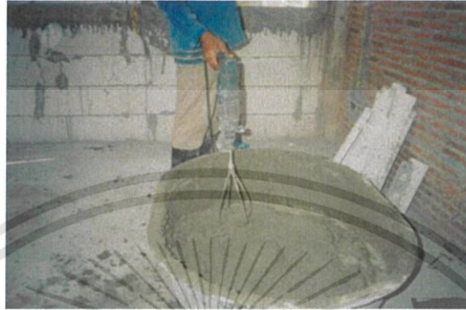
รูปที่ 2.47 ใช้หัวปั่นดัดแปลงกวนคอนกรีต (ที่มาภาพ : ข้อมูลกระบวนการติดตั้งของบริษัท JWS Construction)
