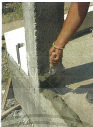
รูปที่ 2.31 ทาปูนก่อด้านข้างบริเวณที่จะก่ออิฐ (ที่มาภาพ : ข้อมูลกระบวนการติดตั้งของบริษัท JWS Construction)
