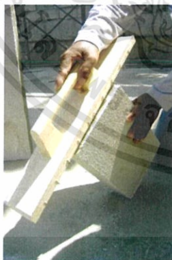
รูปที่ 2.39 ใช้เกรียงฟันปลาขีดให้ผิวอิฐ เรียบเสมอรูปที่ 1
