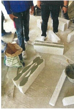
รูปที่ 3.47 ความแตกต่างของปูนก่อบนหน้าอิฐเมื่อใช้เกรียงก่อต่างชนิดกัน
