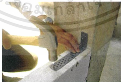
รูปที่ 2.43 ตอกยึด Sheet Plate กับหน้าเสา
