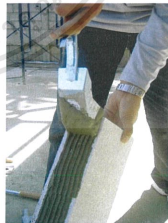
รูปที่ 2.30 ทาปูนก่อด้านบนอิฐมวลเบารูปที่ 2
