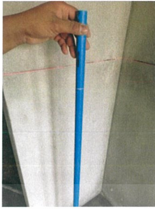
รูปที่ 3.42 ใช้ท่อตรวจเช็คระดับจากการผ่านของเลเซอร์
