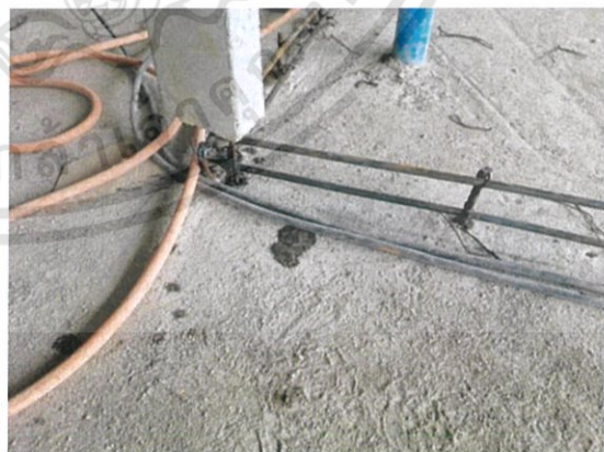
รูปที่ 3.12 ใส่เหล็กปลอกเสริมได้เหล็กคล้ายรูปรั้ว
