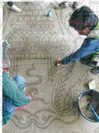
รูปที่ 3.3 การดึงเส้นเชือกตีเส้นไลน์
