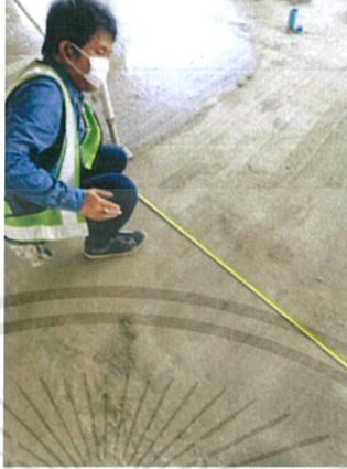
รูปที่ 3.33 การตรวจระยะเส้นไลน์ตามแบบ
