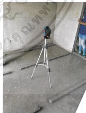
รูปที่ 3.41 ตั้งเลเซอร์ให้ระดับเท่ากับเส้นอ้างอิง
