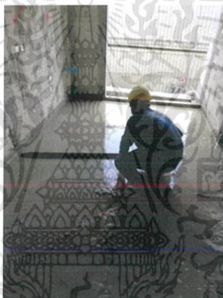
รูปที่ 3.31 ใช้เหล็กสามเหลี่ยมปาดแต่งหน้าปูนให้เรียบ
