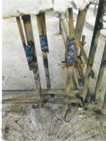
รูปที่ 3.10 การเชื่อมเหล็กติดตายระหว่างเหล็กหนวดกุ้งและเหล็กเสริมเสาเอ็น
