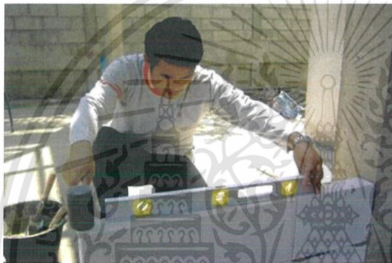
รูปที่ 2.37 การก่ออิฐมวลเบาชั้นที่ 2 (ที่มาภาพ : ข้อมูลกระบวนการติดตั้งของบริษัท JWS Construction)
