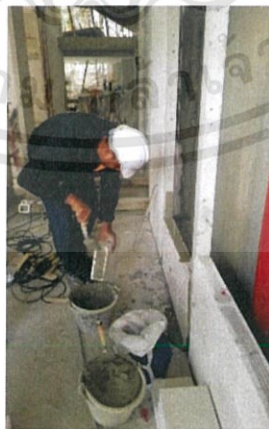
รูปที่ 3.20 ใช้เกรียงก่ออิฐมวลเบาทาปูนก่อด้านข้างอิฐ
