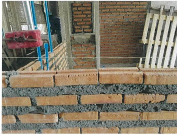
รูปที่ 3.16 การชิงเอ็นกำหนดแนวก่ออิฐมอดู
