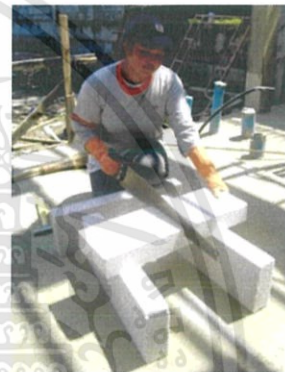
รูปที่ 2.37 การก่ออิฐมวลเบาชั้นที่ 2 (ที่มาภาพ : ข้อมูลกระบวนการติดตั้งของบริษัท JWS Construction)
