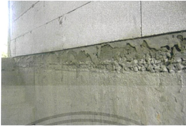
รูปที่ 2.19 การทำคั่นคอนกรีตเสริมเหล็ก (ที่มาภาพ : ข้อมูลกระบวนการติดตั้งของบริษัท JWS Construction)
