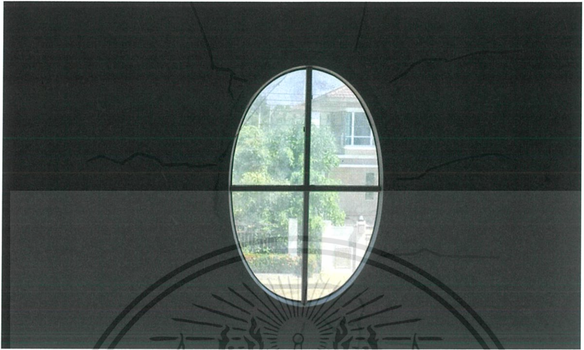
ภาพที่ 4 ตัวอย่างรอยแตกร้าวที่ช่องหน้าต่าง
