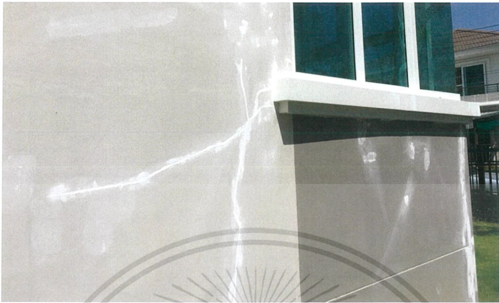
ภาพที่ 14 การเกิดรอยร้าวบริเวณช่องหน้าต่าง
