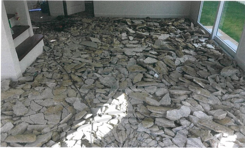
ภาพที่ 10 การเจาะพื้นเพื่อทำการปูกระเบื้องใหม่
