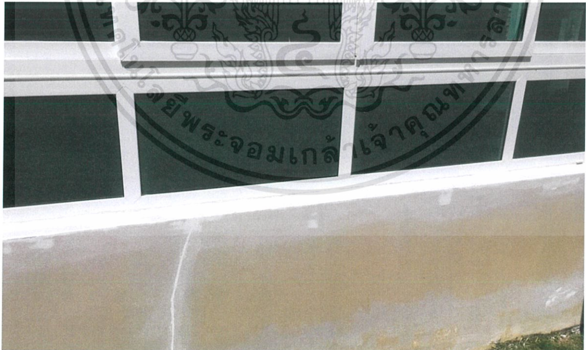
ภาพที่ 5 ตัวอย่างรอยแตกร้าวที่ช่องหน้าต่าง
