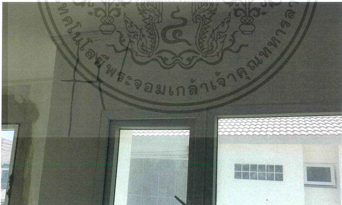
ภาพที่ 3 ตัวอย่างรอยแตกร้าวที่ช่องหน้าต่าง
