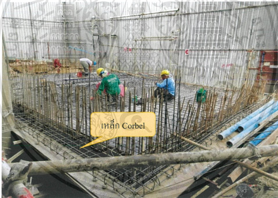
รูปที่ 3-53 ลงเหล็กฝาบ่อ คาน Corbel (ที่มา: โครงการ The privacy thaphra interchange)
