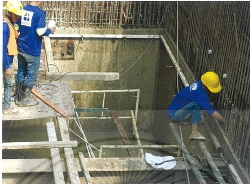
รูปที่ 3-31 ติดตั้ง Water swelling (ที่มา: โครงการ The privacy thaphra interchange)
