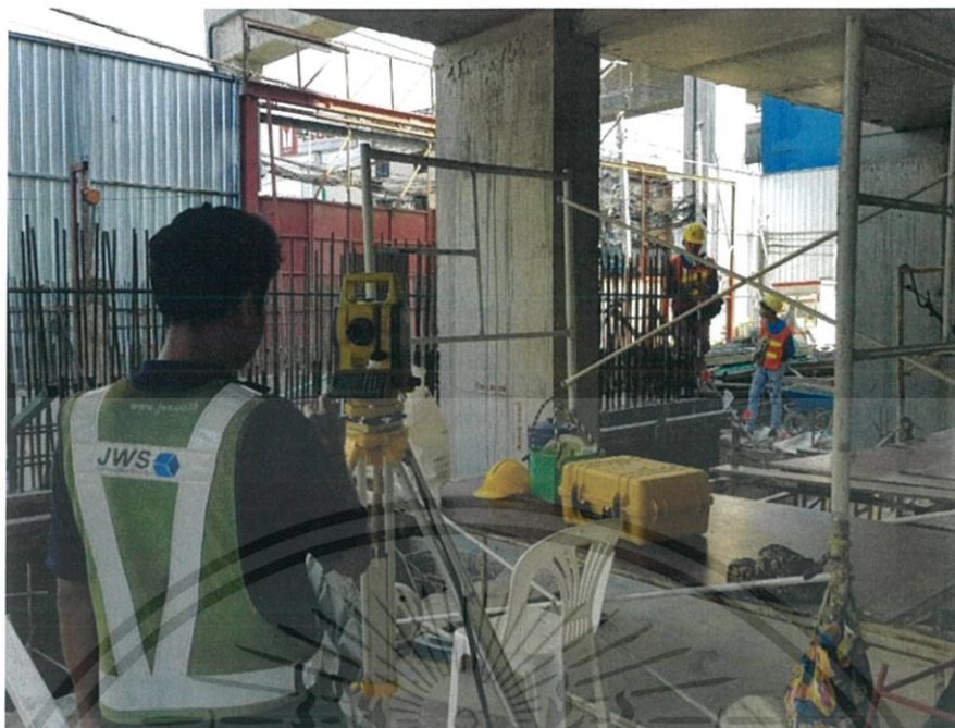
รูปที่ 3-25 ฝ่าย Survey ตรวจสอบค่า Co-ordinate เพื่อเก็บไว้ตรวจสอบการเคลื่อนตัวของบ่อ (ที่มา: โครงการ The privacy thaphra interchange)
