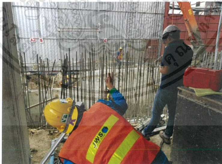
รูปที่ 3-43 ตรวจสอบความต่างระดับของผนังบ่อด้านยาวทั้งสองด้านโดยฝ่าย Survey (ที่มา: โครงการ The privacy thaphra interchange)
