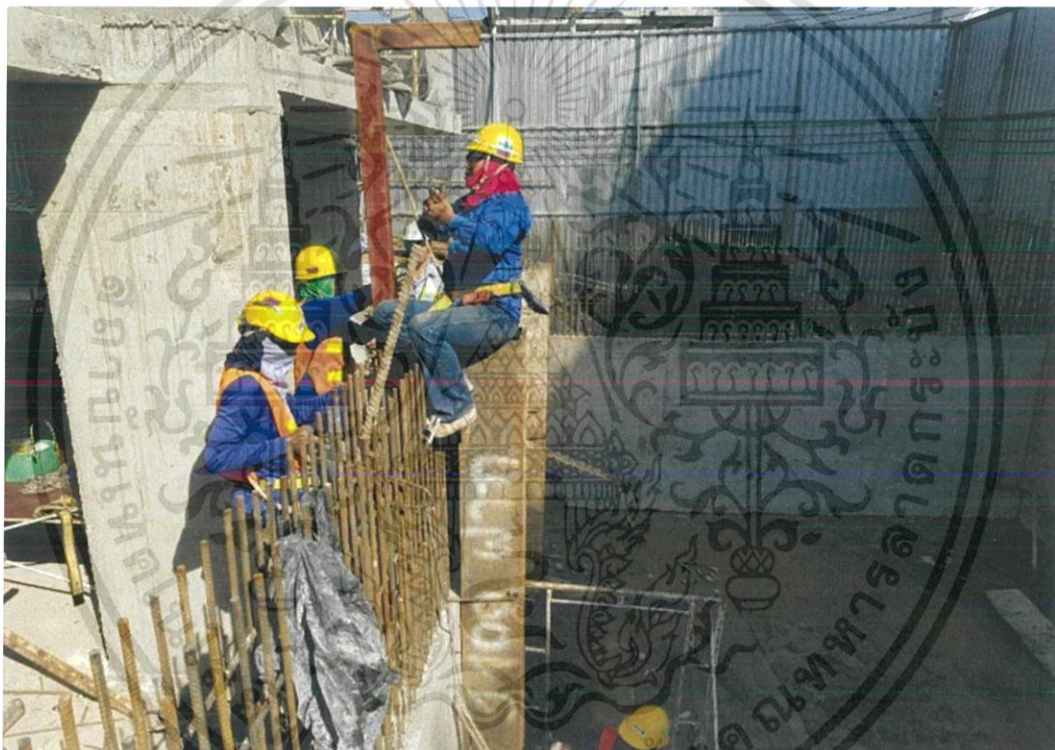
รูปที่ 3-21 ติดตั้งระบบค้ำยัน(Bracing)
