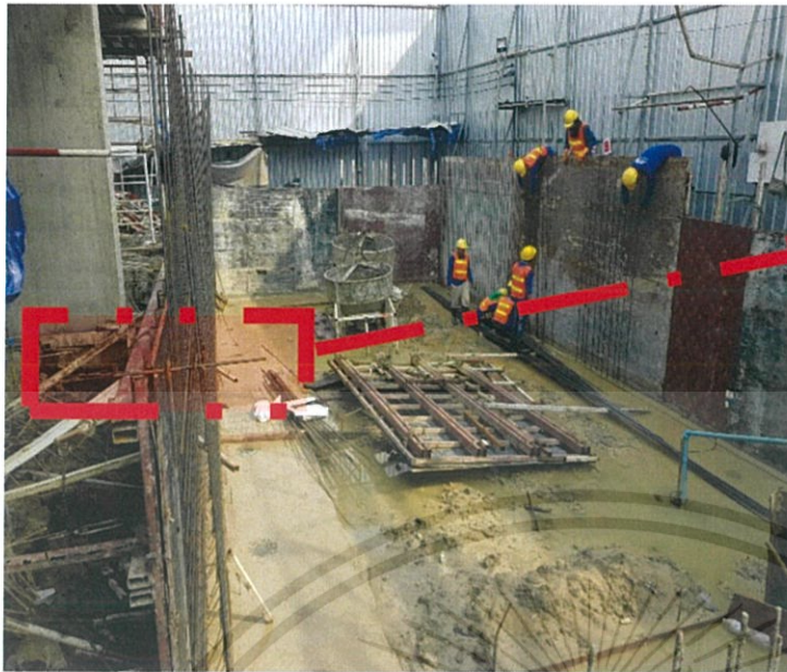
รูปที่ 3-15 เหล็ก Guide ระยะห่างระหว่างเหล็ก (ที่มา: โครงการ The privacy thaphra interchange)
