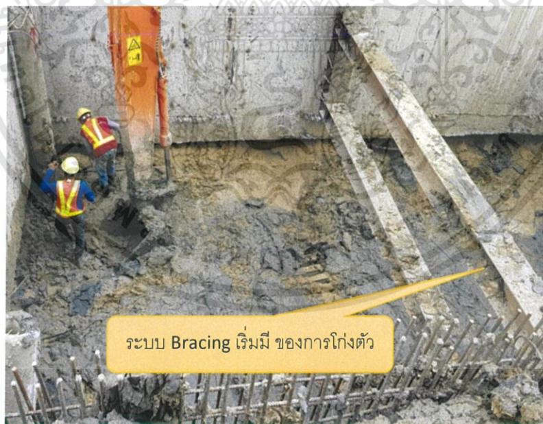
รูปที่ 3-35 ระบบค้ำยันเริ่มมีการโก่งตัวเนื่องจากแรงดันดิน (ที่มา: โครงการ The privacy thaphra interchange)
