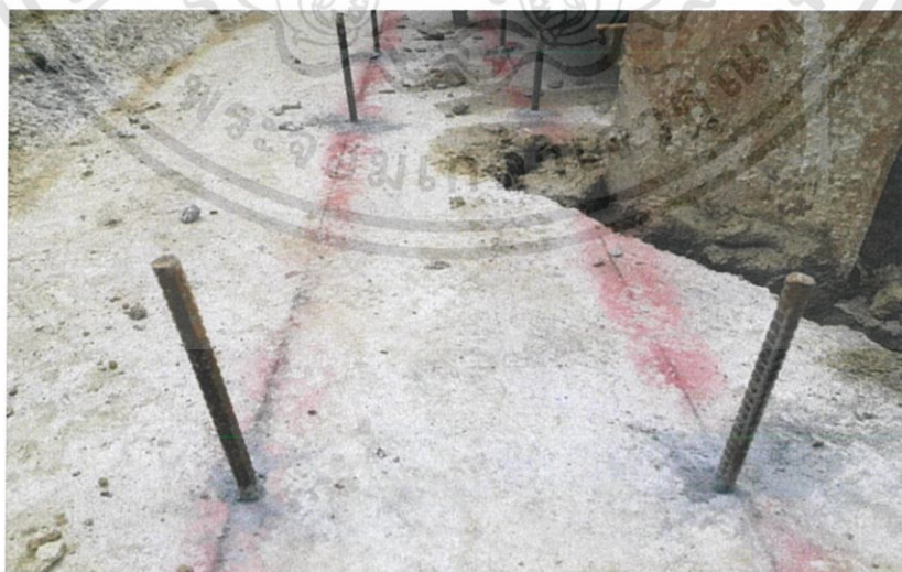
รูปที่ 3-14 เหล็ก Guide ที่ดินผนังเพื่อไม่ให้ความหนาผนังเปลี่ยนแปลงไป
