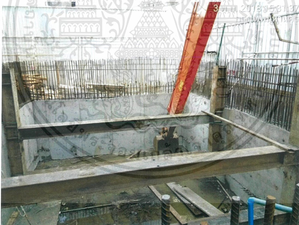
รูปที่ 3-23 ลองแนวสวิงของแขนเบ็คโฮหลังติดตั้งระบบค้ำยัน(Bracing)
