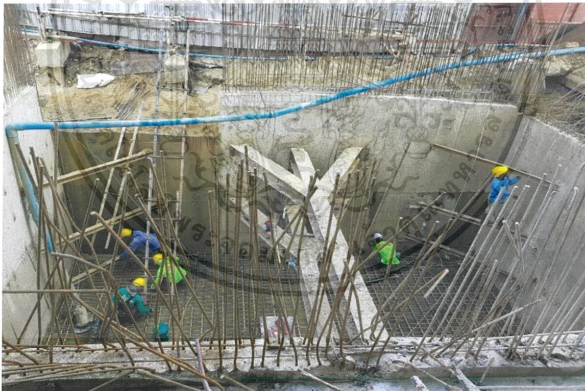
รูปที่ 3-49 ลงเหล็กพื้นบ่อ (ที่มา: โครงการ The privacy thaphra interchange)
