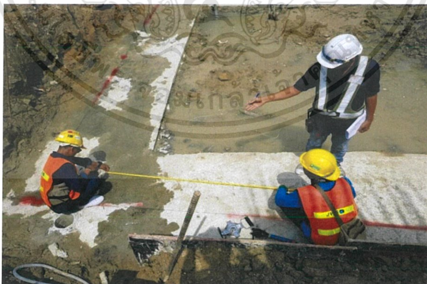
รูปที่ 3-9 ฝ่าย Survey ให้เส้นแนวผนังโดยอ้างอิงจากเส้น Gridline (ที่มา: โครงการ The privacy thaphra interchange)
