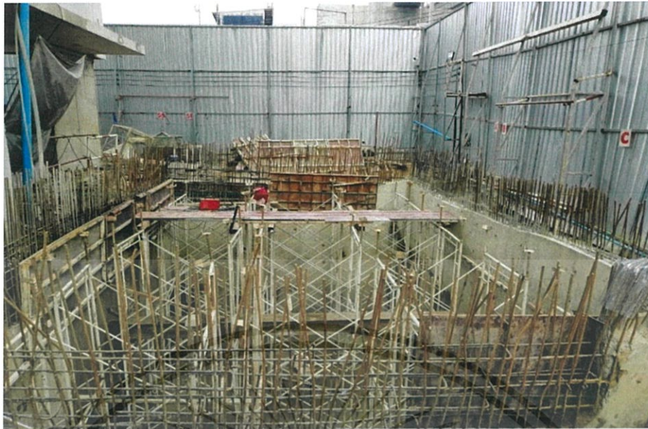
รูปที่ 3-52 ตั้งนั่งร้านปูไม้แบบรองรับฝาบ่อและคาน (ที่มา: โครงการ The privacy thaphra interchange)
