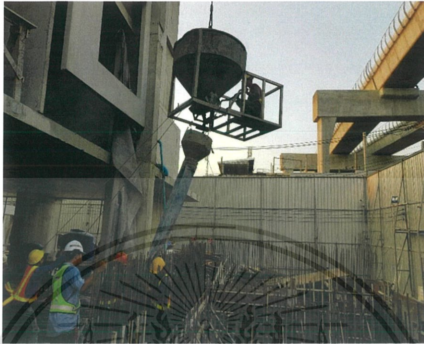
รูปที่ 3-33 เทคอนกรีตผนังบ่อ Step 2 (ที่มา: โครงการ The privacy thaphra interchange)
