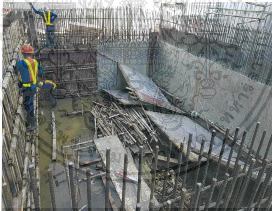
รูปที่ 3-20 แกะแบบผนังบ่อหนองน้ำ (ที่มา: โครงการ The privacy thaphra interchange)
