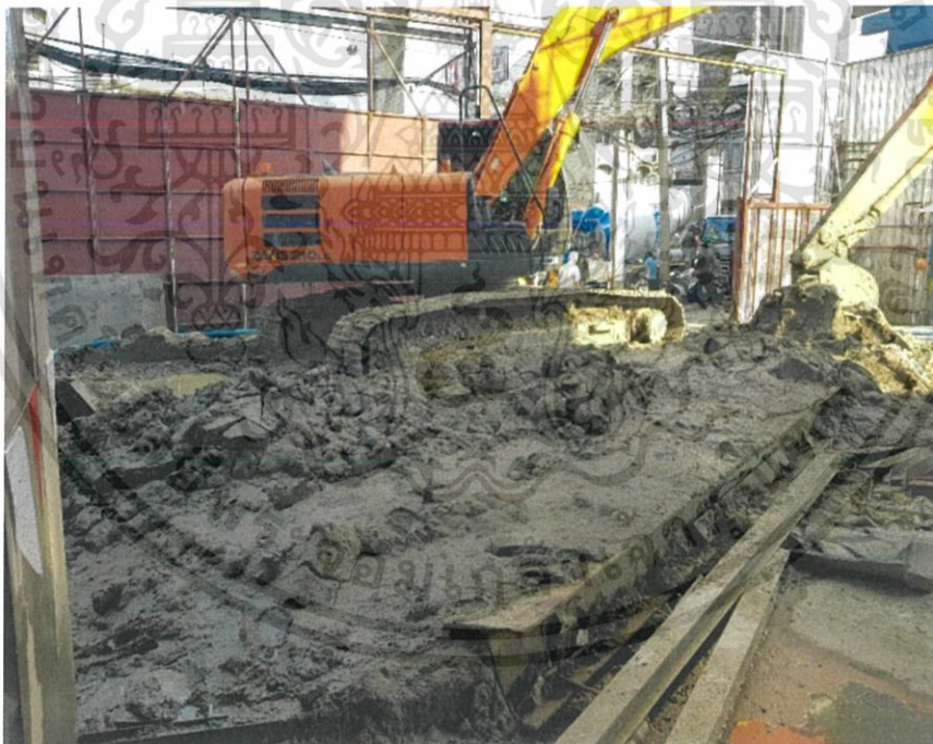
รูปที่ 3-39 การStock ดินในไซตให้แห้งก่อนการขนไปทิ้ง (ที่มา: โครงการ The privacy thaphra interchange)
