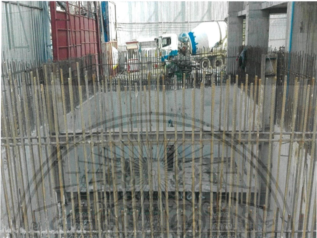
รูปที่ 3-24 ออกแบบการติดตั้งระบบค้ำยัน(Bracing)เพื่อความสะดวกในการชุดของแบ็คโฮ (ที่มา: โครงการ The privacy thaphra interchange)
