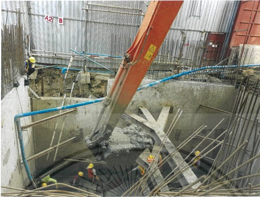
รูปที่ 3-38 การสูบน้ำที่เอ่อขึ้นมาตลอดด้วยเครื่องสูบน้ำและการขุดไปสกัดหัวเข็มไป (ที่มา: โครงการ The privacy thaphra interchange)
