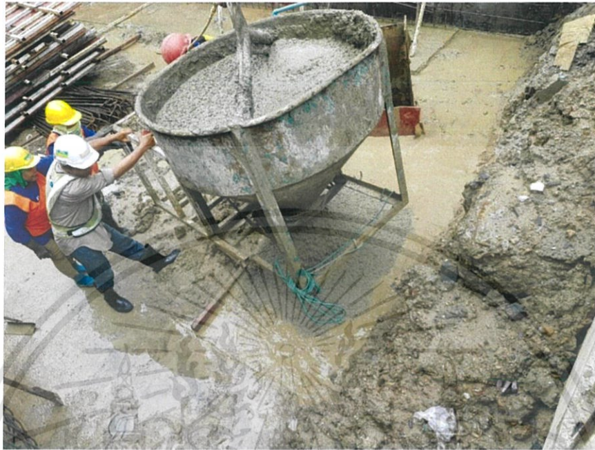
รูปที่ 3-6 เทคอนกรีตหยาบรอบบ่อเพื่อความสะดวกในการทำงานลำดับถัดไป (ที่มา: โครงการ The privacy thaphra interchange)
