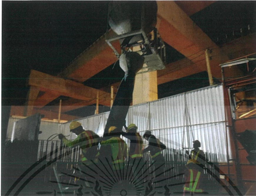
รูปที่ 3-19 เทคอนกรีตผนัง Step ที่ 1 โดยใช้ Bucket (ที่มา: โครงการ The privacy thaphra interchange)
