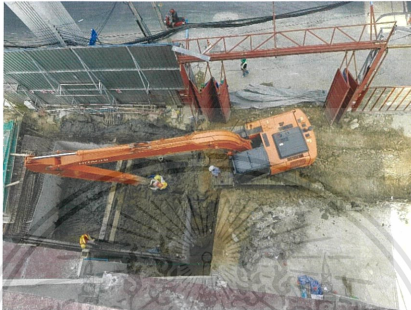
รูปที่ 3-34 ทำการขุดเพื่อทำการถมของบ่อ Step 2 (ที่มา: โครงการ The privacy thaphra interchange)
