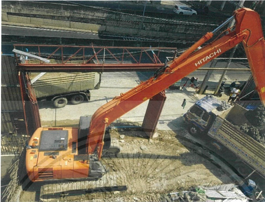
รูปที่ 3-40 การStock ดินในไซต์ให้แห้งก่อนการขนไปทิ้ง (ที่มา: โครงการ The privacy thaphra interchange)
