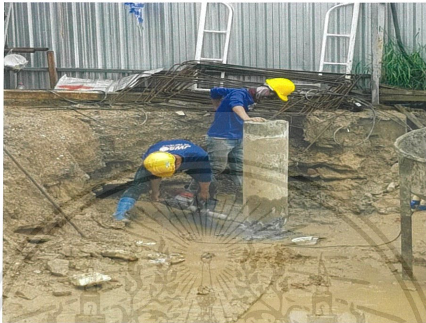
รูปที่ 3-8 ตัดเสาเข็มเพื่อง่ายต่อการทำงานในลำดับถัดไป (ที่มา: โครงการ The privacy thaphra interchange)
