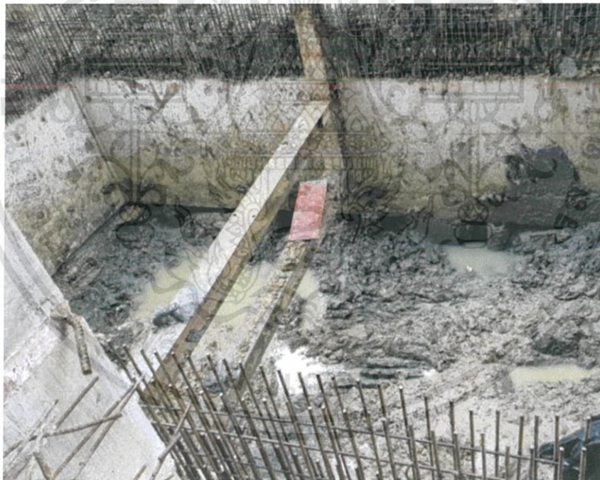
รูปที่ 3-37 ผนังเคลื่อนตัวมาเทินบนหัวเสาเข็ม (ที่มา: โครงการ The privacy thaphra interchange)
