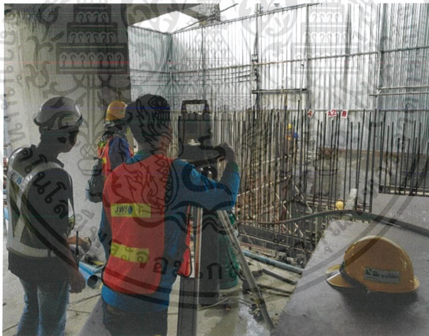
รูปที่ 3-32 ตรวจสอบค่า Co-ordinate ปีก่อนเทพนัง Step 2 (ที่มา: โครงการ The privacy thaphra interchange)
