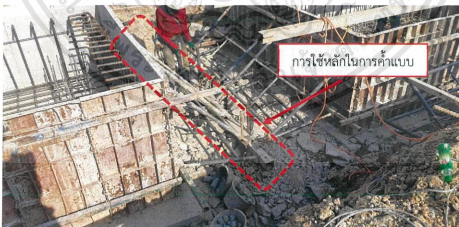
ภาพที่ 3.26 ภาพการค้ำแบบกับหลักที่สร้างขึ้น
