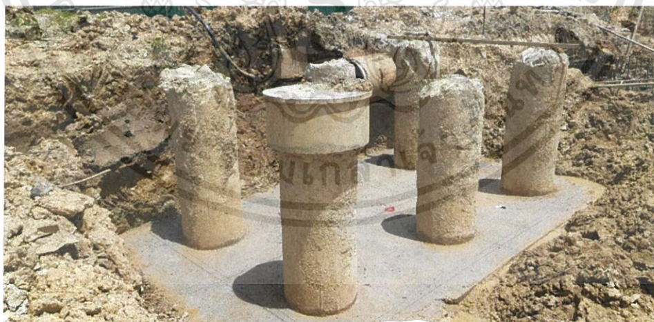
ภาพที่ 3.11 ภาพการวางแนวฐานรากบนลิ้น (ที่มา: โรงพยาบาลแม่สอดอินเตอร์เนชั่นแนล)
