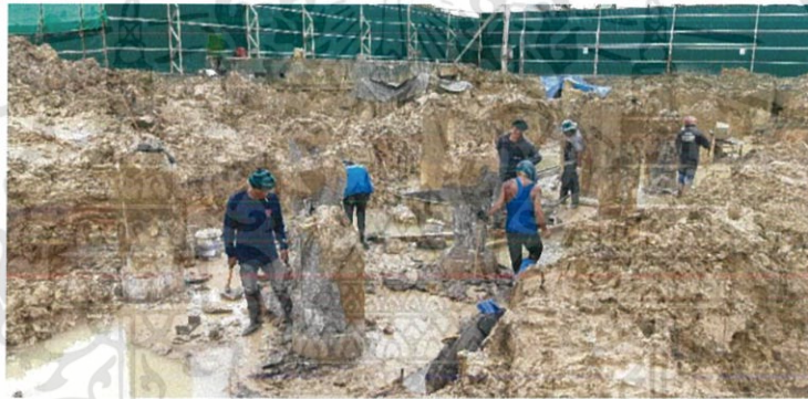
ภาพที่ 3.12 ภาพการตัดหัวเข็ม 1 (ที่มา: โรงพยาบาลแม่สอดอินเตอร์เนชั่นแนล)
