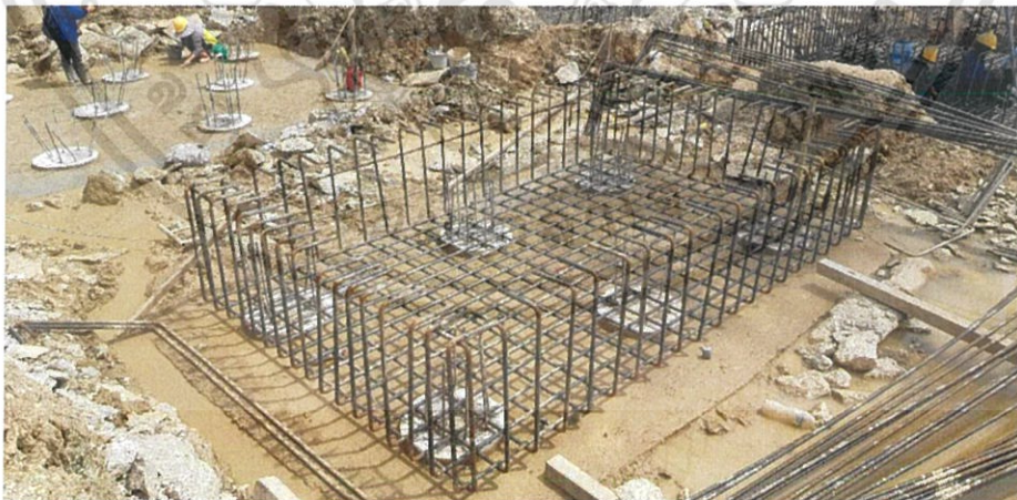
ภาพที่ 3.22 ภาพการวางเหล็กฐานราก (ที่มา: โรงพยาบาลแม่สอดอินเตอร์เนชั่นแนล)
