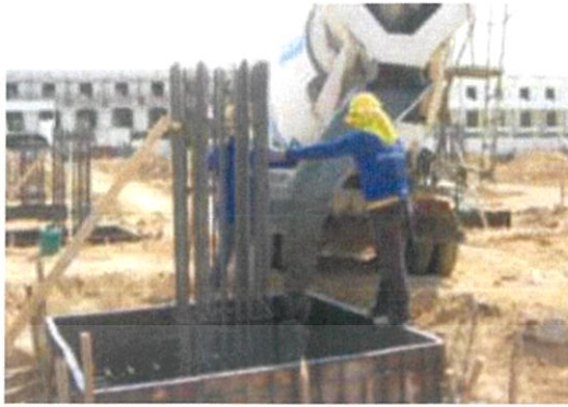
ภาพที่ 2.11 ภาพแสดงการเทคอนกรีตฐานรากและแสดงการถอดแบบฐานราก (ที่มา: วิทยาลัยสัตหีบ, เอกสารการสอน เรื่องการควบคุมงานก่อสร้าง)
