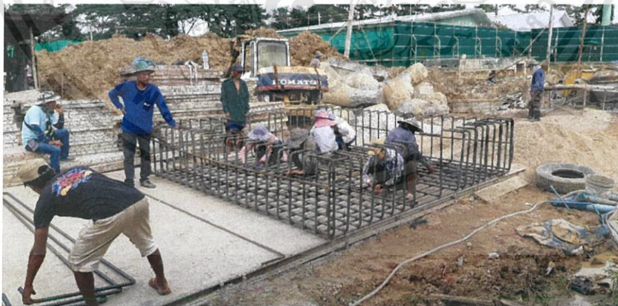
ภาพที่ 3.16 ภาพตัวอย่างเหล็กฐานราก (ที่มา: โรงพยาบาลแม่สอดอินเตอร์เนชั่นแนล)
