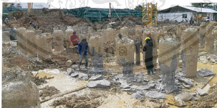
ภาพที่ 3.13 ภาพการตัดหัวเข็ม 2 (ที่มา: โรงพยาบาลแม่สอดอินเตอร์เนชั่นแนล)
