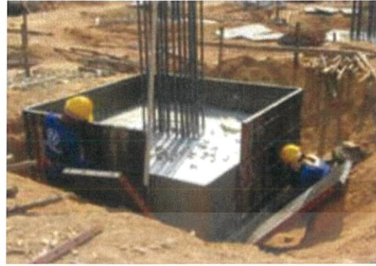
ภาพที่ 2.11 ภาพแสดงการเทคอนกรีตฐานรากและแสดงการถอดแบบฐานราก (ที่มา: วิทยาลัยสัตหีบ, เอกสารการสอน เรื่องการควบคุมงานก่อสร้าง)
