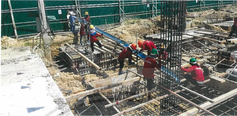
ภาพที่ 3.33 ภาพการเทคอนกรีตจากรถคอนกรีต 2 (ที่มา: โรงพยาบาลแม่สอดอินเตอร์เนชั่นแนล)
