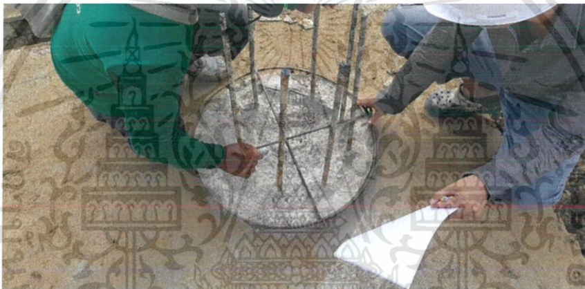
ภาพที่ 3.19 ภาพการหาศูนย์กลางเสาเข็ม (ที่มา: โรงพยาบาลแม่สอดอินเตอร์เนชั่นแนล)
