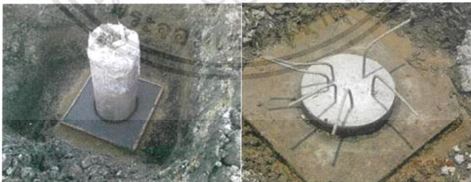
ภาพที่ 2.5 ภาพเสาเข็มเจาะ
