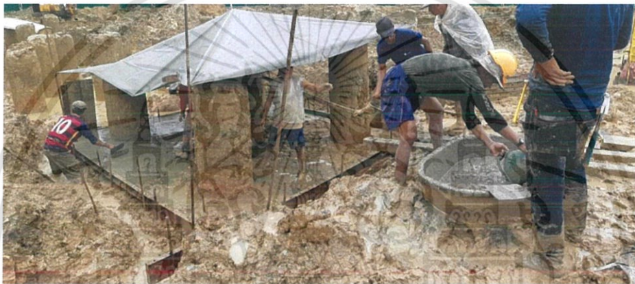
ภาพที่ 3.10 ภาพเทลิ้นฐานราก (ที่มา: โรงพยาบาลแม่สอดอินเตอร์เนชั่นแนล)
