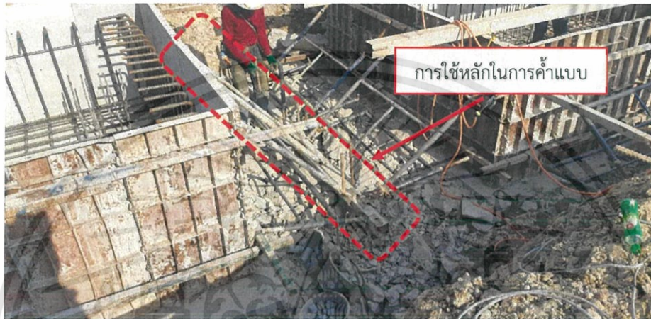
ภาพที่ 4.2 ภาพลักษณะการค้ำแบบด้วยหลัก (ที่มา: โรงพยาบาลแม่สอดอินเตอร์เนชั่นแนล)
