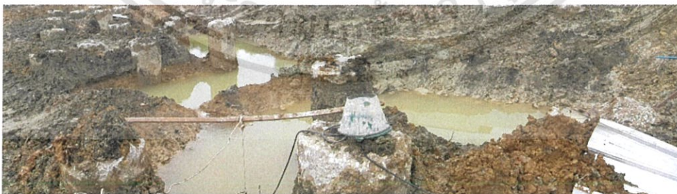
ภาพที่ 3.9 ภาพปัญหาน้ำขังหลุมที่ขุดฐานราก (ที่มา: โรงพยาบาลแม่สอดอินเตอร์เนชั่นแนล)
