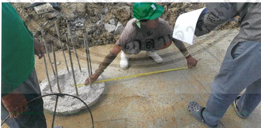
ภาพที่ 3.20 การหาระยะเยื้องศูนย์เสาเข็ม (ที่มา: โรงพยาบาลแม่สอดอินเตอร์เนชั่นแนล)
