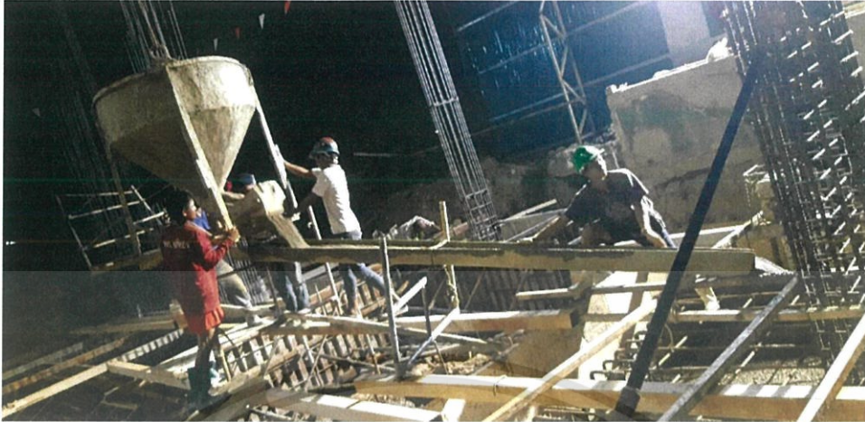
ภาพที่ 3.31 ภาพการเทคอนกรีตด้วย Pockets 2 (ที่มา: โรงพยาบาลแม่สอดอินเตอร์เนชั่นแนล)
