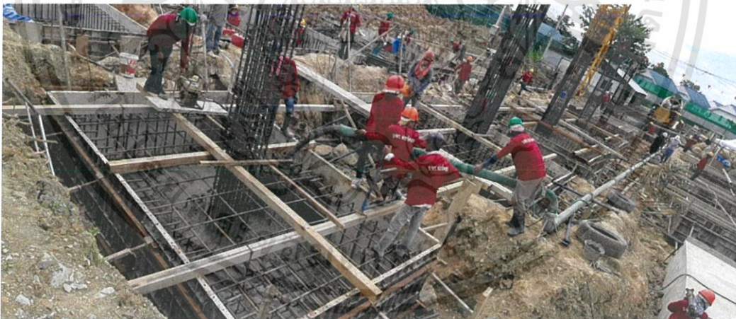
ภาพที่ 3.29 ภาพการเทคอนกรีตด้วย Station Pump (ที่มา: โรงพยาบาลแม่สอดอินเตอร์เนชันแนล)
