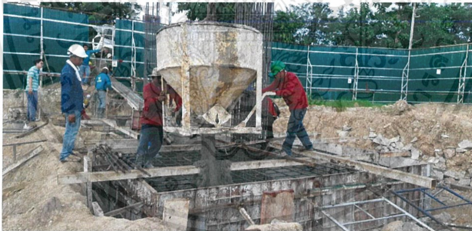
ภาพที่ 3.30 ภาพการเทคอนกรีตด้วย Pockets 1 (ที่มา: โรงพยาบาลแม่สอดอินเตอร์เนชั่นแนล)
