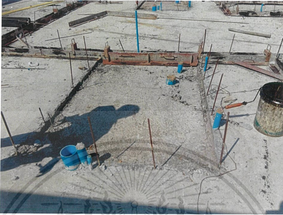
รูปที่4.1 การเข้าแบบ kicker ผนัง1 ระบบ Tunnel-Precast (T-P) (2)
