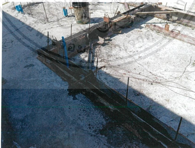
รูปที่ 4.1 การเข้าแบบ kicker ผนัง 1 ระบบ Tunnel-Precast (T-P) (1)
