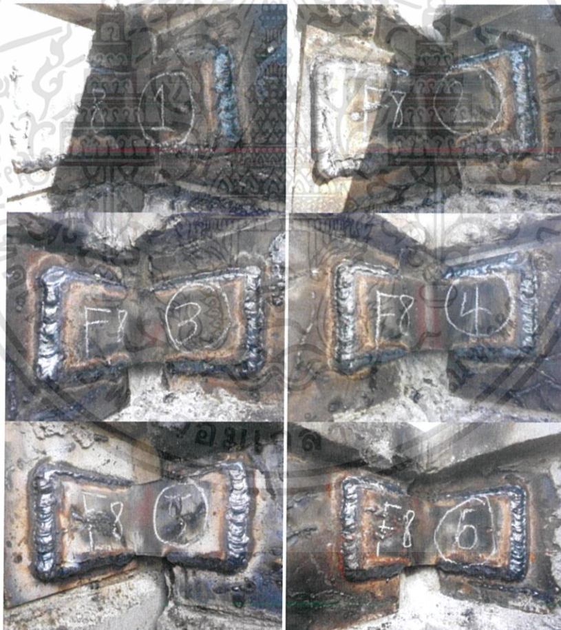
รูปที่4.10 การตรวจสอบรอยเชื่อมหลังติดตั้งชิ้นส่วน Precast
