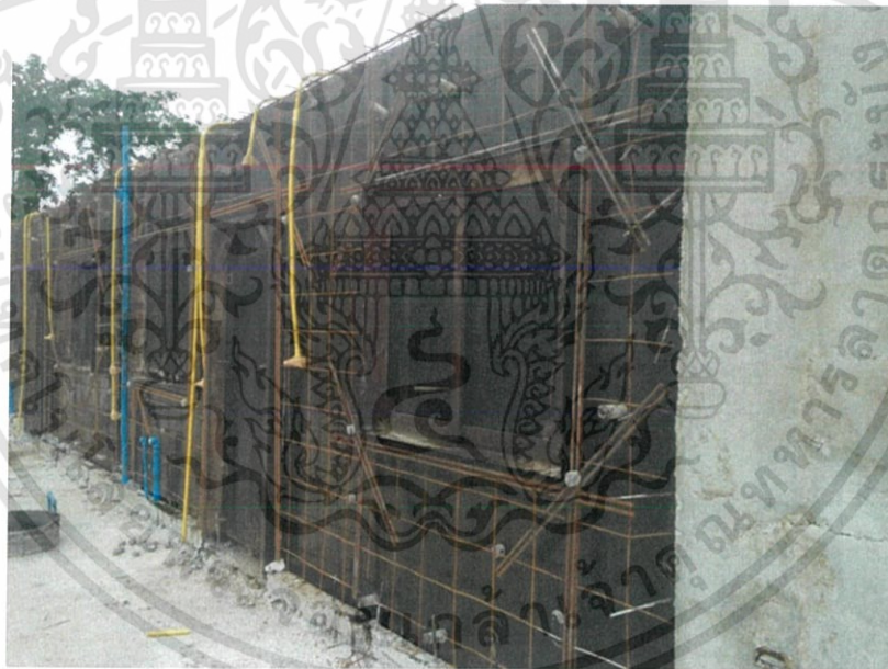
รูปที่4.18 แบบเหล็ก (Formwork) ที่ใช้ในการก่อสร้างบ้านทาวน์เฮาส์
