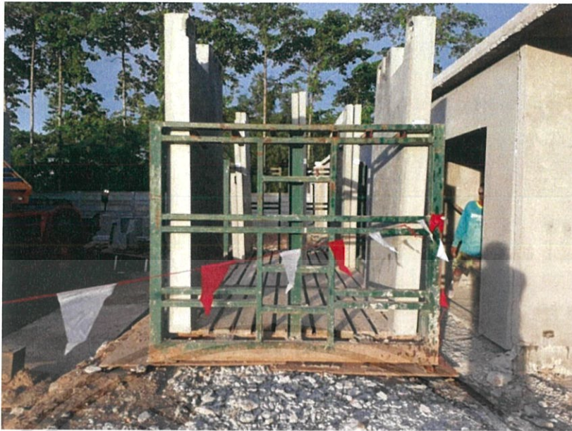
รูปที่ 4.22 การจัดเก็บชิ้นงาน Precast ผนังงาน
