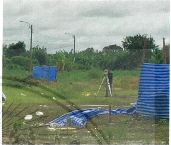
ภาพที่ 3.13 ทีมเซอร์เวย์เช็คระดับหัวฐานราก
