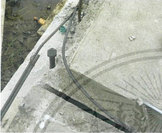
ภาพที่ 3.30 ตัว Bolt มีลักษณะเป็นน็อตชั้นเกลียวขนาดใหญ่ ทำหน้าที่ปรับระดับและรับน้ำหนักกำแพง
