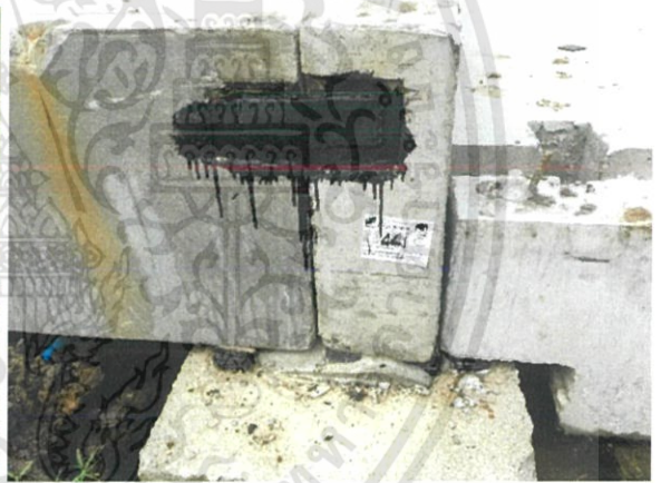
ภาพที่ 3.23 เหล็กที่เชื่อมกันแล้วทาสีกันสนิม
