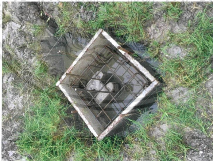
ภาพที่ 3.11 เหล็กที่เชื่อมแล้วได้ถอดออกมาจากโครงสร้างฐานราก คือเหล็ก Dowel ที่เสียบเข้าท่อคอลลูเกต (ที่มา : รูปจากหน้างานจริง)
