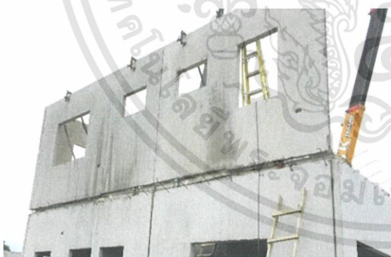
ภาพที่ 3.52 แผ่นผนังชั้นที่ 2 ยกมาวาง
