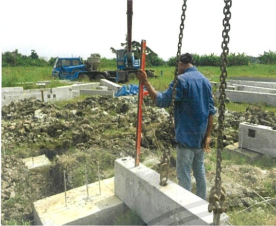
ภาพที่ 3.20 ลูกน้ำเซีกระดบหลังคาน
