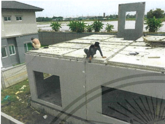
ภาพที่ 3.51 ใส่ Bolt ตามรูให้ครบตามแบบ
