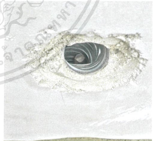
ภาพที่ 3.37 ตัวอย่างท่อคอลลูเกตที่ฝังอยู่ในผนัง
