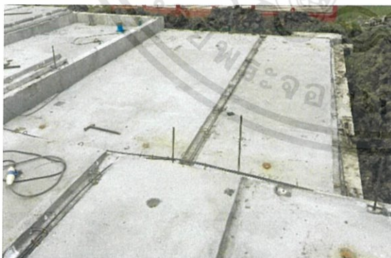
ภาพที่ 3.26 ใส่เหล็ก Starter ให้ครบ ร้อยเชื่อมต่อ กันทุกแผ่น
