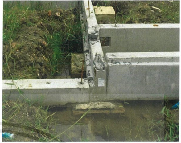
ภาพที่ 3.21 ปูน Non-Shrink หลังจากแห้งแล้ว
