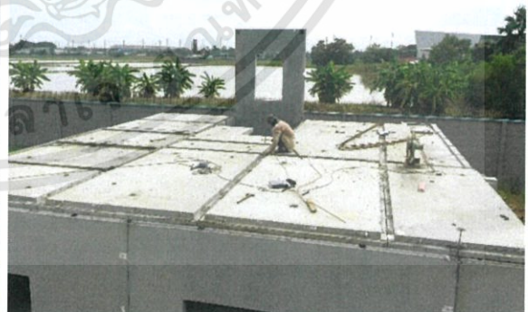
ภาพที่ 3.49 ใส่เหล็ก Starter ให้ครบ
