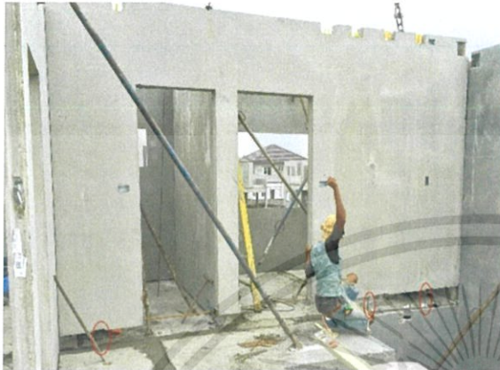
ภาพที่ 3.54 วงกลมสีแดง คือ เหล็ก Dowel ที่ใส่ ที่คอคูลูเกตของผนังชั้น 2
