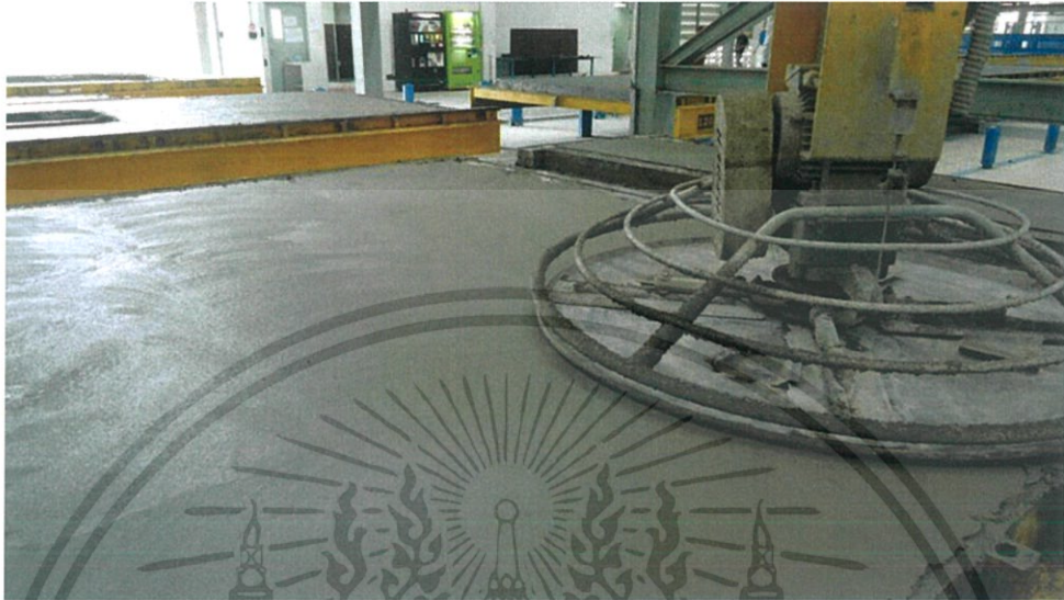
ภาพที่ 2.21 ชัดผิวหน้าคอนกรีต
