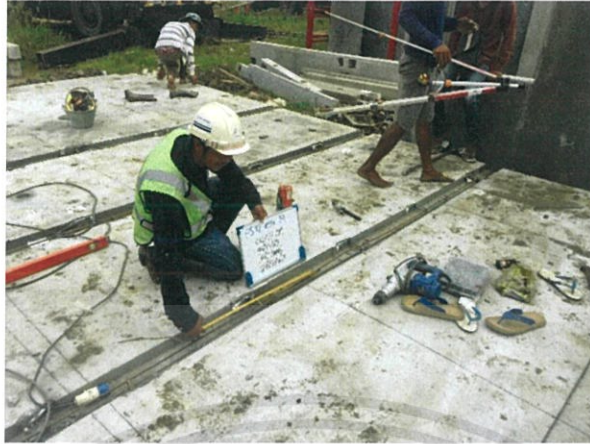
ภาพที่ 3.27 วิศวกรควบคุมการติดตั้งเช็คเหล็กทั้ง 3 คือ Dowel Loop และ Starter รวมทั้งระยะทาบ
