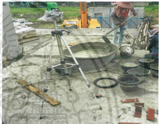
ภาพที่ 3.35 ตัวเลเซอร์เช็คระดับผนังให้เท่ากัน
