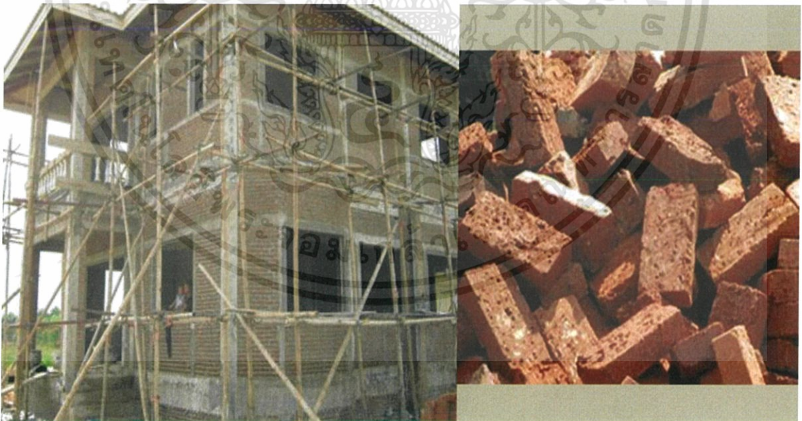
ภาพที่ 2.1 การก่อสร้างบ้านด้วยอิฐมอญฉาบ
