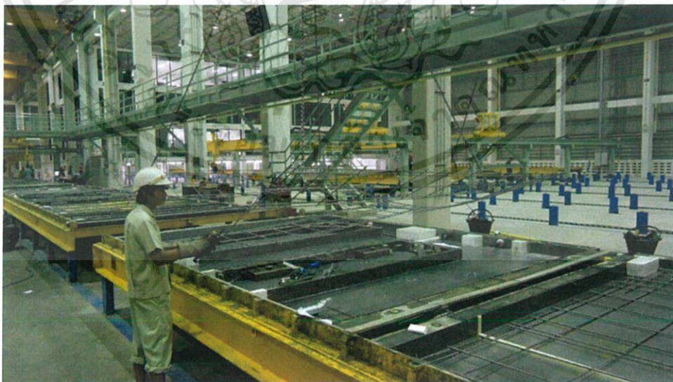
ภาพที่ 2.18 วางโครงเหล็ก
