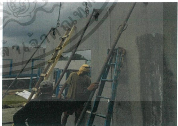
ภาพที่ 3.33 ตัวอย่างเส้นไลน์ที่ออฟเซตจากขอบด้านบนผนังลงมาตามที่กำหนดไว้
