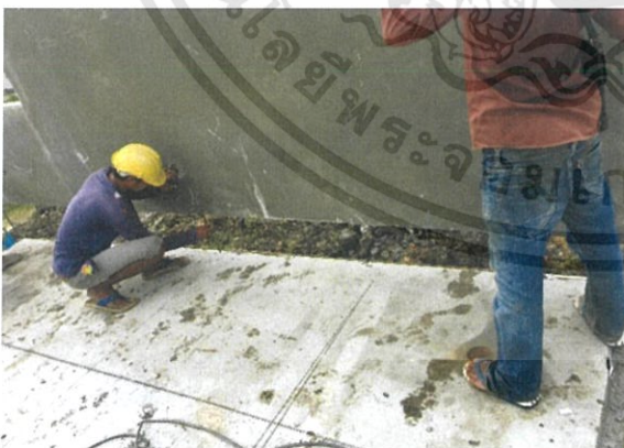
ภาพที่ 3.32 ตัวอย่างเส้นไลน์ที่ออฟเซตจากขอบพื้นที่แต่ละด้าน 1 เมตร
