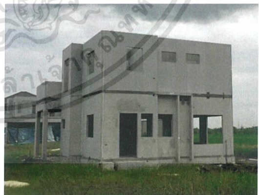
ภาพที่ 3.62 เสร็จเรียบร้อยสำหรับขั้นตอนการก่อสร้าง บ้านด้วยระบบ Fully Precast
