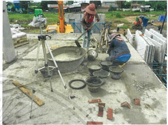
ภาพที่ 3.50 กรอกปูน Non-Shrink ลงระหว่างแผ่นพื้น
