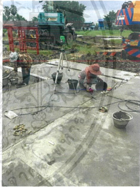
ภาพที่ 3.29 กรอกปูน Non-Shrink ให้ครบทุกช่อง
