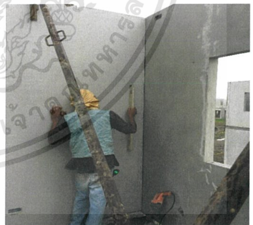
ภาพที่ 3.53 ใช้ลู่น้ำเช็ดการเอียงของแผ่นผนัง
