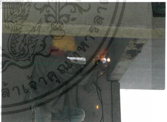
ภาพที่ 3.45 เชื่อมเพลตด้านใน
