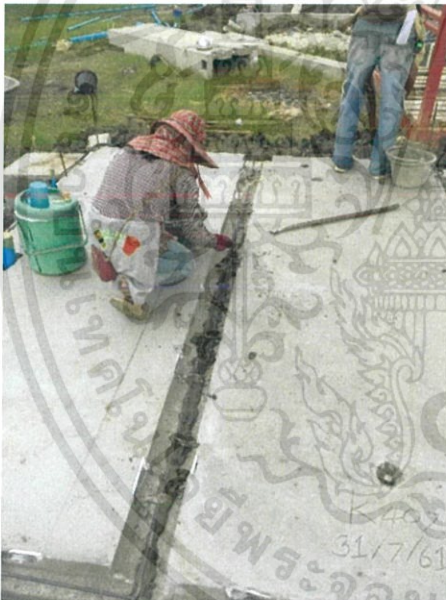
ภาพที่ 3.28 กรอกปูน Non-Shrink ลงตามช่องระหว่างแผ่นพื้นให้ครบ
