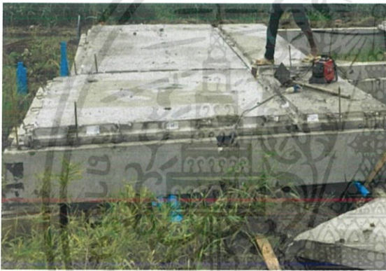
ภาพที่ 3.24 เจาะรูที่คานตามตำแหน่งที่กำหนดไว้ ใส่ น้ำยาผสมอีพ็อกซี แล้วเสียบเหล็กให้ครบตามแบบ
