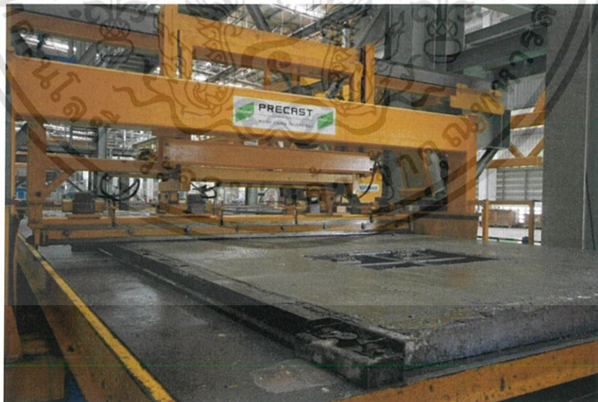
ภาพที่ 2.20 ปาดหน้าคอนกรีต
