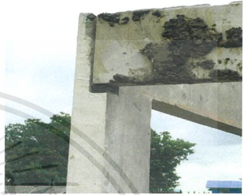
ภาพที่ 3.46 สำหรับคานถ้าระดับไม่ได้ ให้ใช้ซิมเฟลตเป็นตัวปรับระดับ
