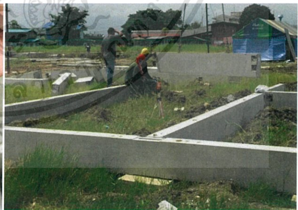
ภาพที่ 3.19 เลเซอร์คอยเช็คระดับหลังคาน
