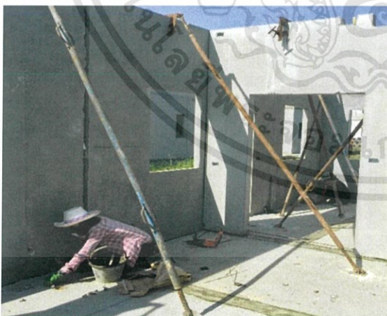
ภาพที่ 3.36 ตัวอย่างผนังที่ปรับทั้งระดับและระยะออฟเซตแล้ว
