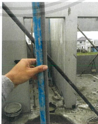
ภาพที่ 3.40 ตัวอย่างแผ่นผนัง 2 แผ่นที่ใส่ Backing Rod และกรอกปูน Non-Shrink แล้ว
