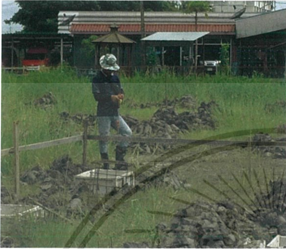
ภาพที่ 3.12 ทีมเซอร์เวย์เช็คระดับหัวฐานราก
