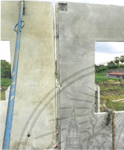
ภาพที่ 3.38 เหล็ก Loop ระหว่างผนังแต่ละแผ่น
