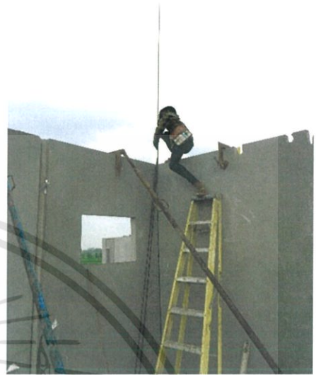
ภาพที่ 3.55 ใส่เหล็ก Starter ระหว่าง แผ่นผนัง
