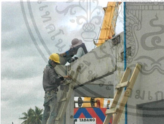
ภาพที่ 3.44 เชื่อมเพลตด้านนอก
