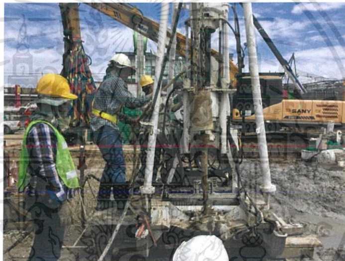
รูป 4.8 การทดสอบ Standard Penetration Test
