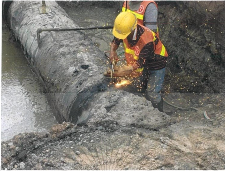
รูป 4.19 ถอนงานระบบที่อยู่ใต้ดินบริเวณทำงาน
