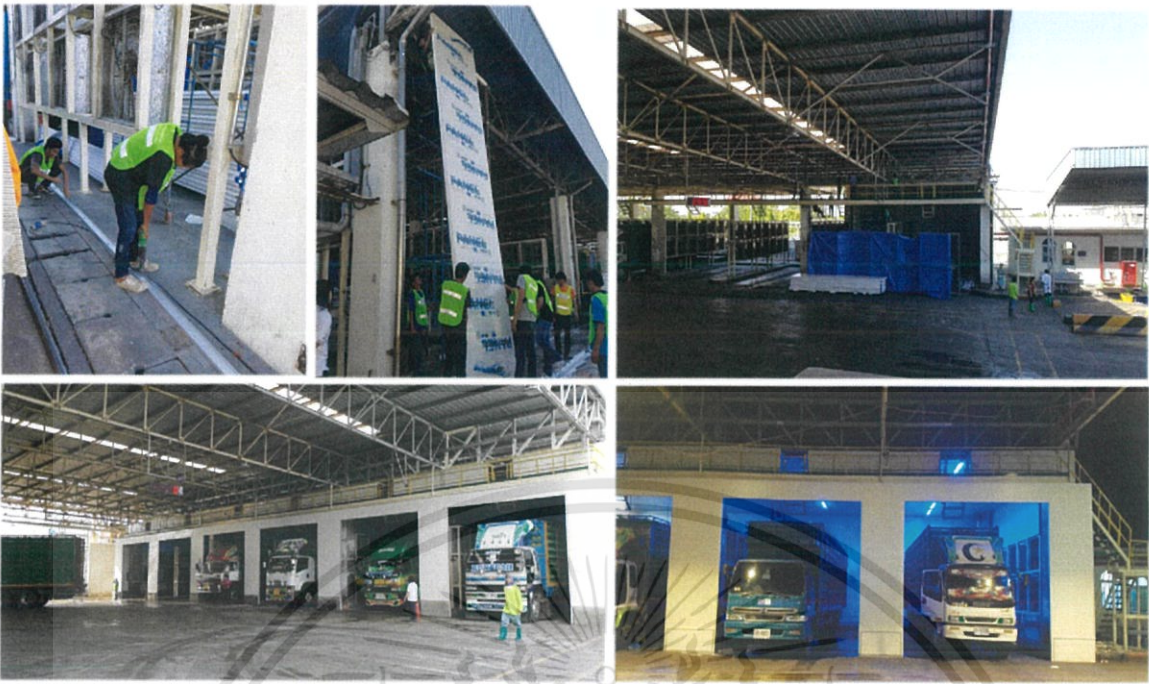
รูปที่ 4.19 การปรับปรุงโครงสร้าง(อยู่ระหว่างดำเนินการ)
