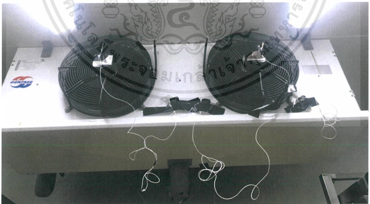
รูปที่ 10-ก การวัดอุณหภูมิอากาศที่ผ่านเครื่องระเหย
