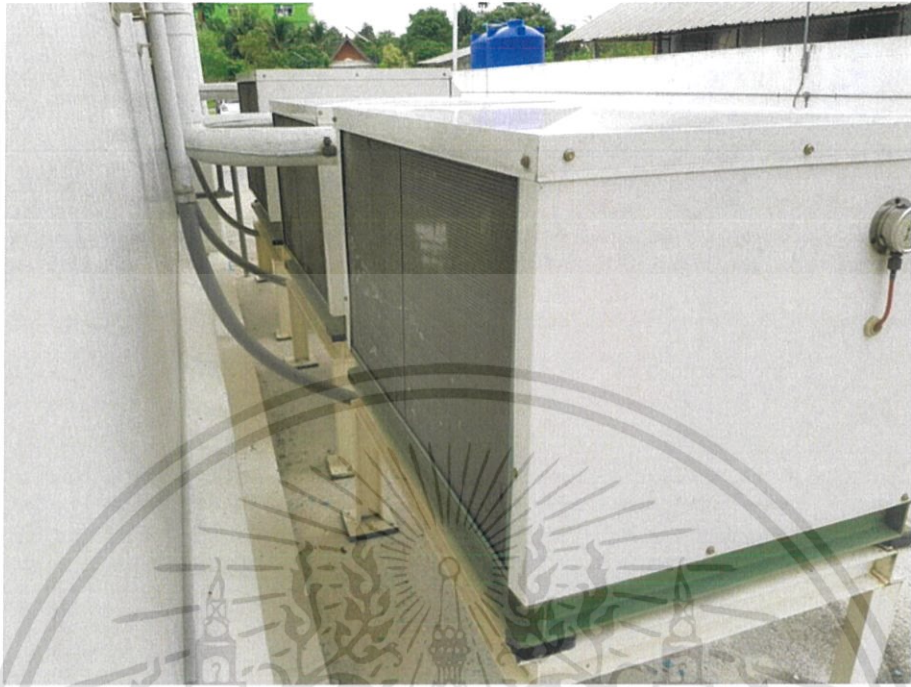
รูปที่ 3-ก เครื่องควบแน่นด้านลมเข้า
