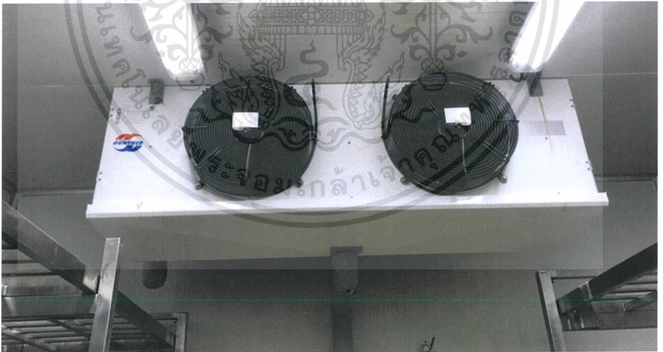
รูปที่ 6-ก เครื่องระเหยด้านลมออก
