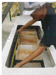
รูปที่ 3.29 การวัดความยาวของพื้นที่สำหรับออกแบบแผ่นประคอง
