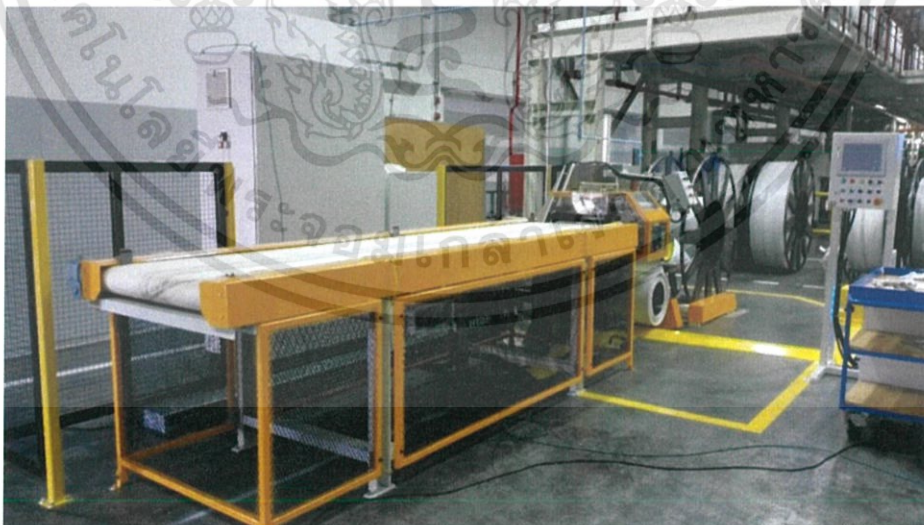
ภาพที่ 59 แสดงตำแหน่งติดตั้งเครื่องจักรในพื้นที่จริง (ด้านหน้า)
