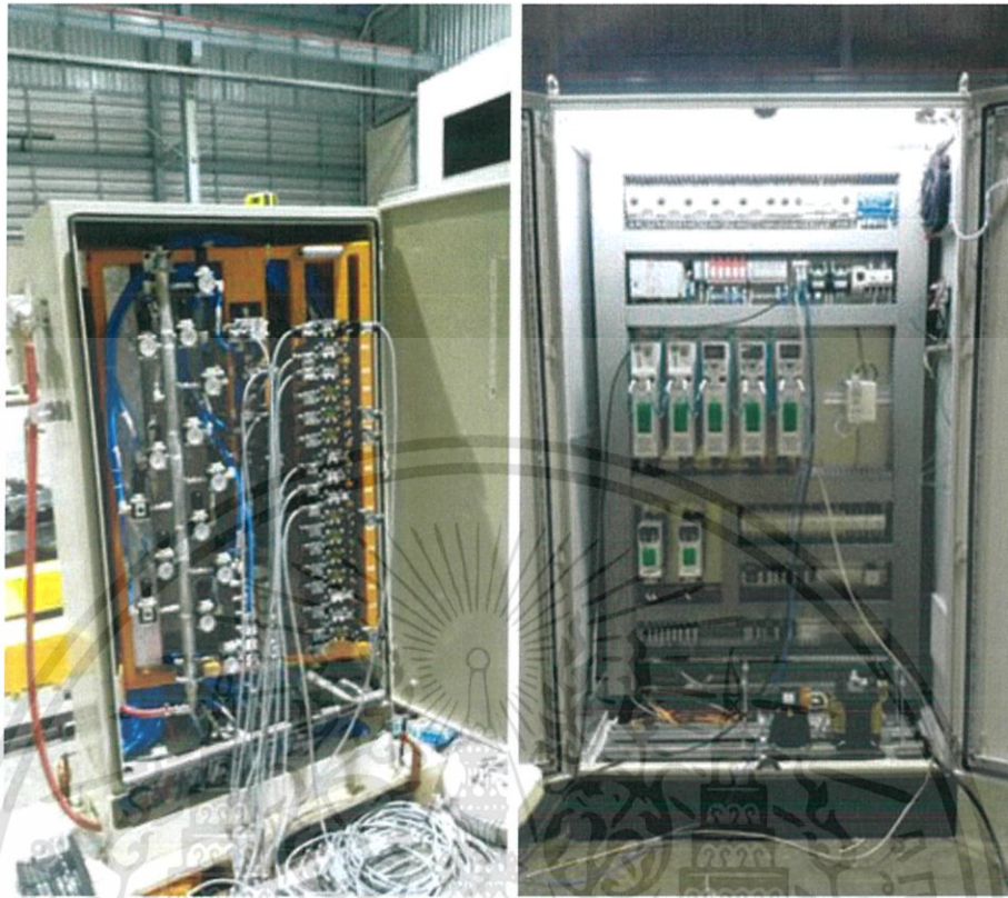
ภาพที่ 49 แสดงภาพการประกอบตู้ควบคุม(CP PKM) ช้าย และตู้ไฟฟ้าหลัก(AG) ขวา
