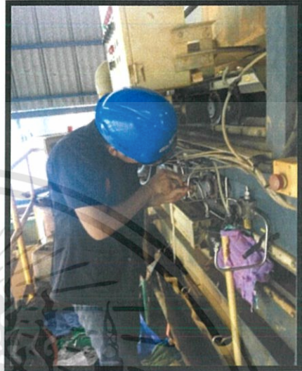
ภาพที่ 3.17 การไข Tube กับ Fitting เข้ากัน
