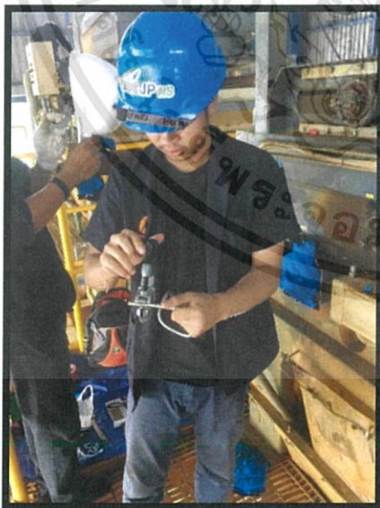
ภาพที่ 3.14 ตัวอย่างการตัด Tube
