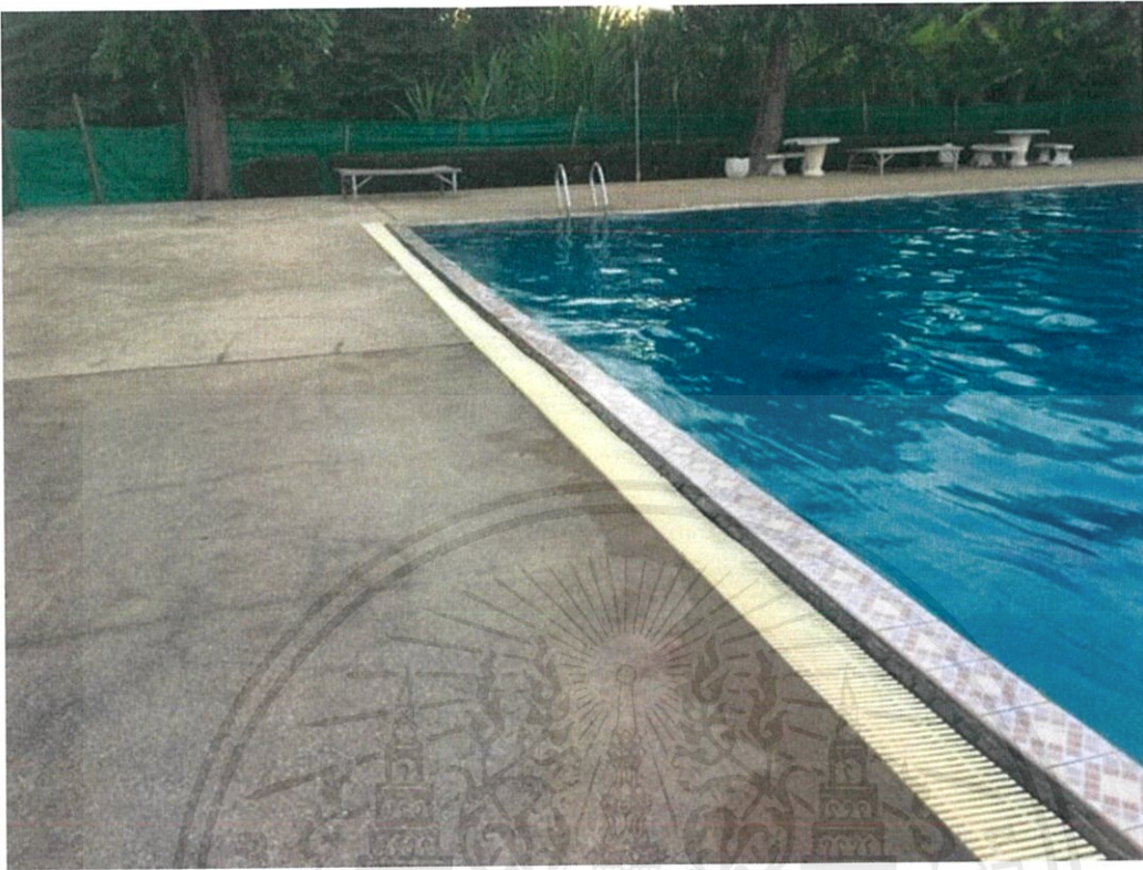
ภาพที่ 3.2 สระว่ายน้ำ
