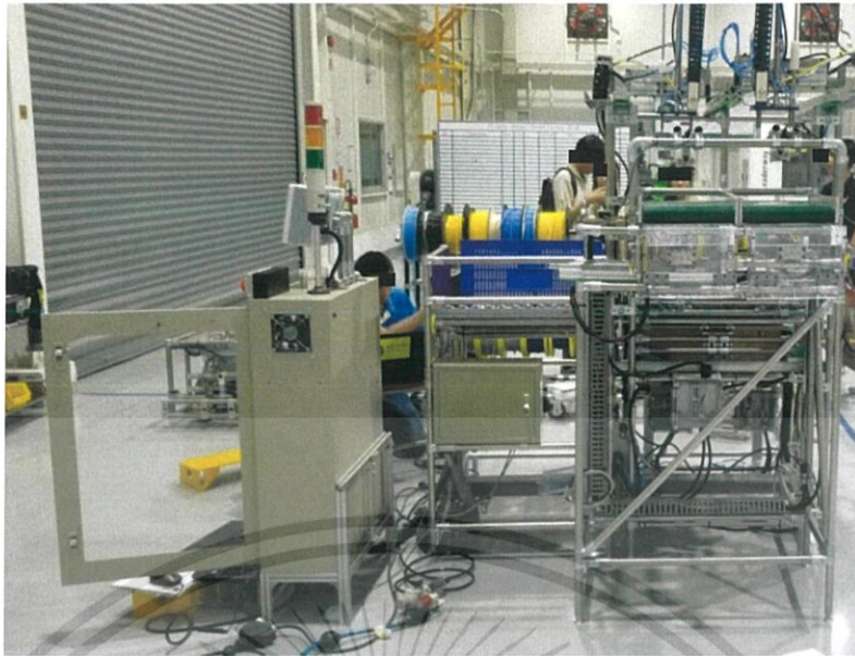
รูปที่ 4.6 ติดตั้งตู้ควบคุมไฟฟ้าใกล้กับเครื่องบรรจุอัตโนมัติ
