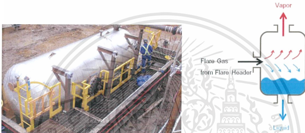
รูปที่ 2.4 ตัวอย่างและการทำงานของ Knock-Out Drum
