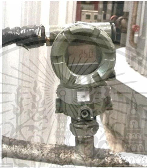
รูปที่ 2.23 Pressure Transmitter
