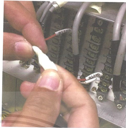
รูปที่ 4.10 การพันเทปกาวปิดสายไฟ
