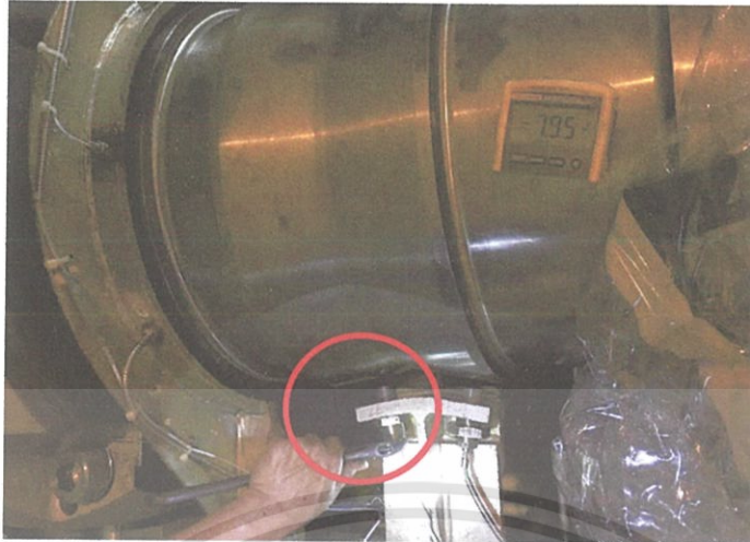
รูปที่ 4.27 การตั้งค่า Gap ของ Ramp Differential Expansion (LP)
