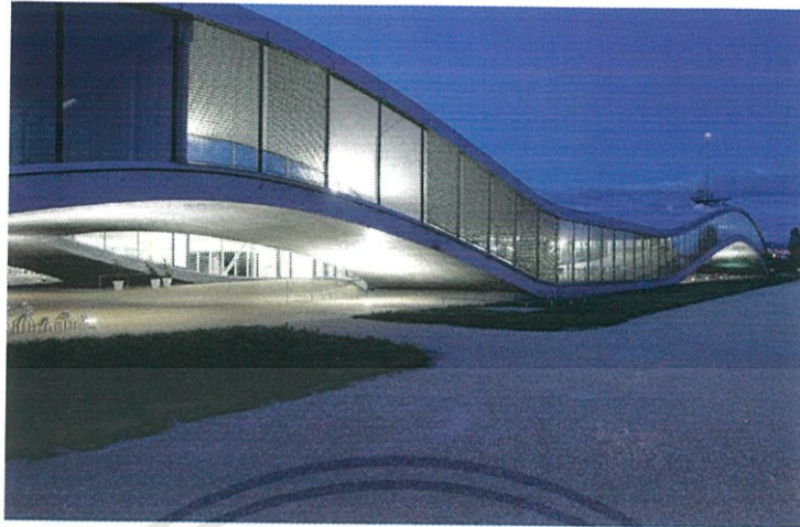
รูปที่ 1. 41 รูปภาพบรรยากาศภายนอกอาคาร
