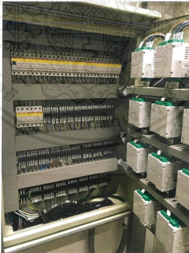
ภาพที่ 3.17 การติดตั้งเพาเวอร์มิเตอร์ภายในตู้ควบคุม
