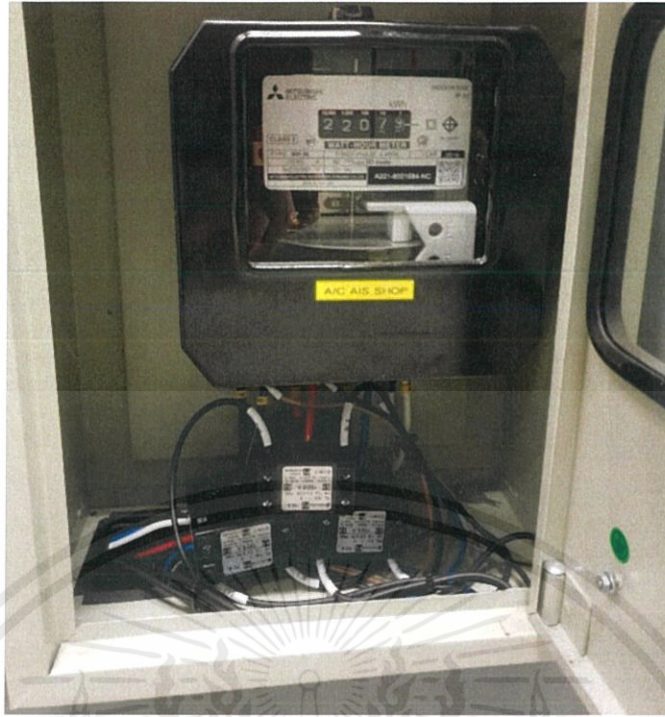
ภาพที่ 3.14 การคล้อง CT จากเพาเวอร์มิเตอร์เดิมภายในอาคาร
