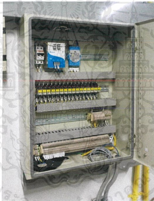
ภาพที่ 3.21 การติดตั้ง I/O Module ภายในตู้ควบคุม
