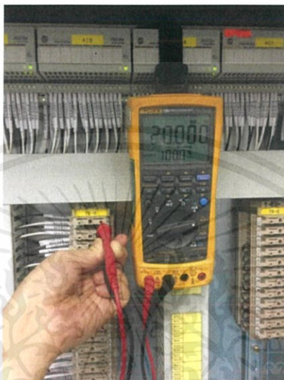
รูปที่ 4.14 การทดสอบ Analog Input แบบ 4 wire
