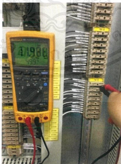
รูปที่ 4.13 การทดสอบ Analog Input แบบ 2 wire
