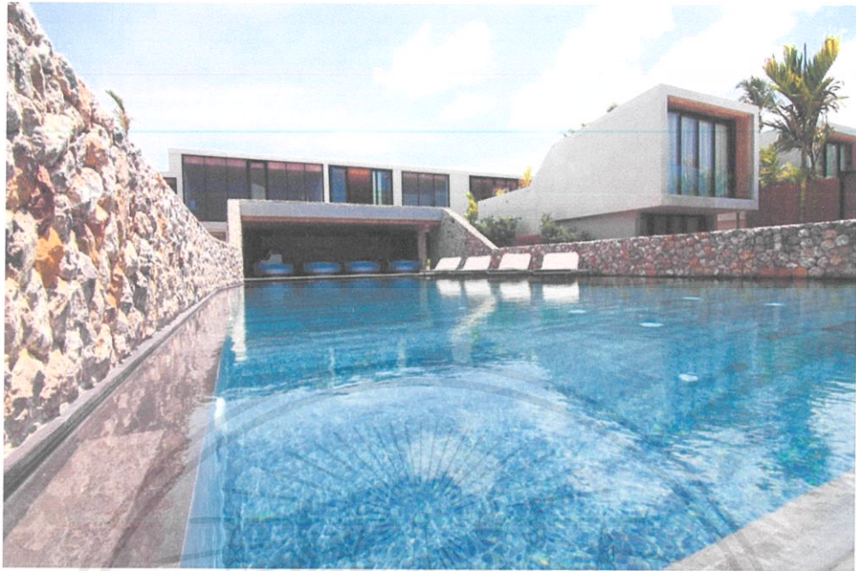
ภาพที่ 17 สระว่ายน้ำส่วนกลางของ CASA DE LA FLORA
