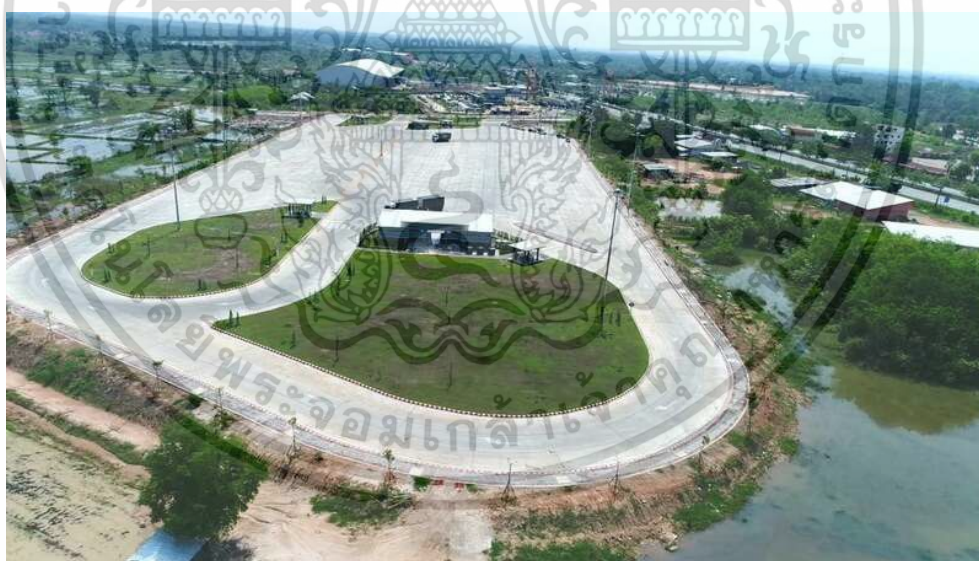
ภาพที่ 2.4 บริเวณภายในพื้นที่โดยรอบจุดจอดพักรถบรรทุกสถานีตรวจสอบน้ำหนัก โนนสูง(ขาออก) จังหวัดนครราชสีมา
